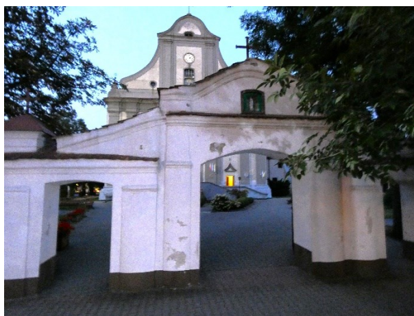
Fot. 14. Ogrodzenie zespołu klasztornego w Żurominie
