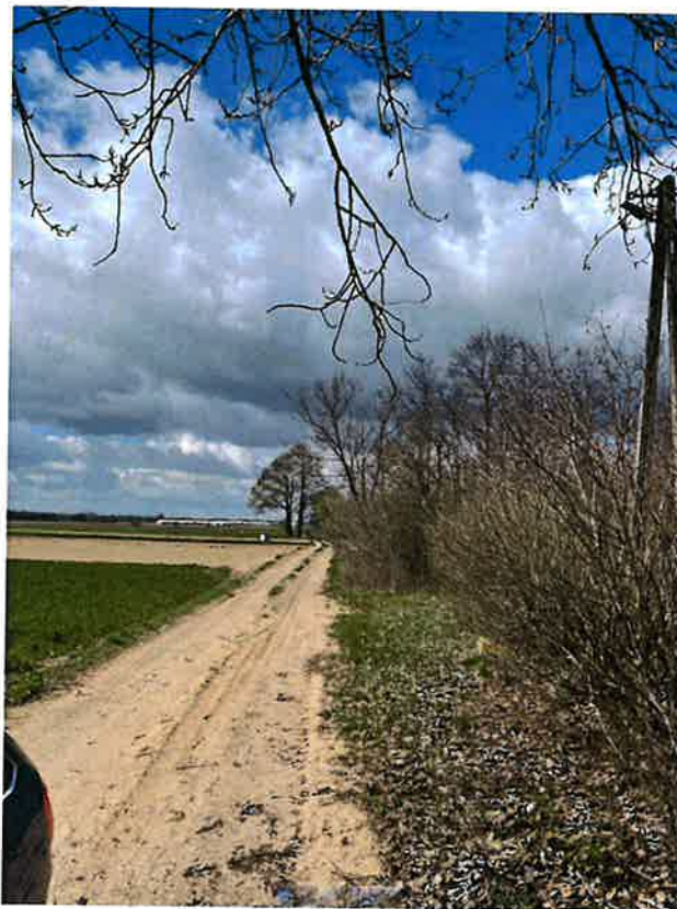
Fot. 1 – widok na odcinek drogi gminnej objętej przebudową
