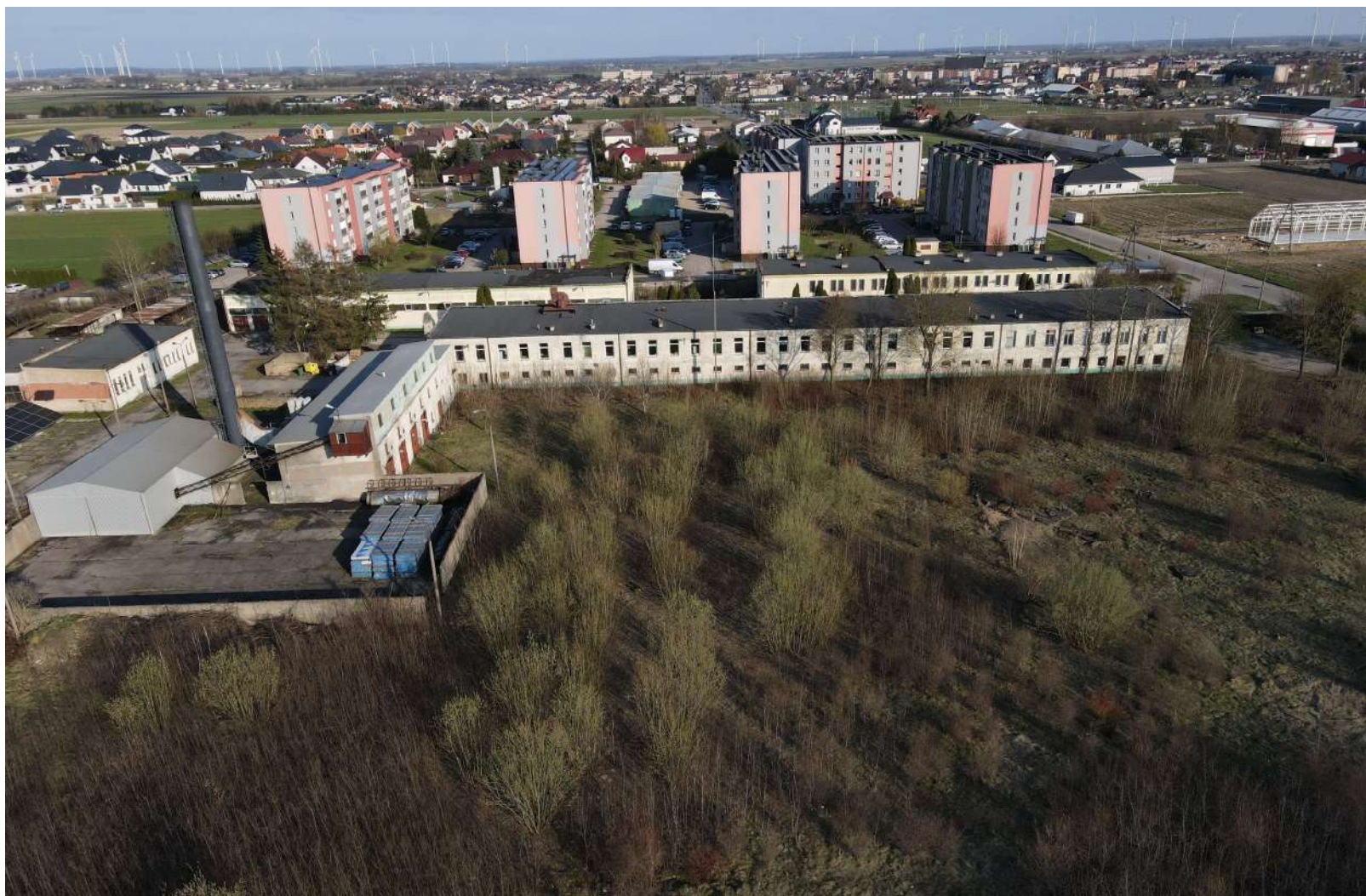
Ryc 9. Widok na sąsiedztwo od strony wschodniej do centrum miasta kotłownia oraz sąsiednia zabudowa wielorodzinna.
