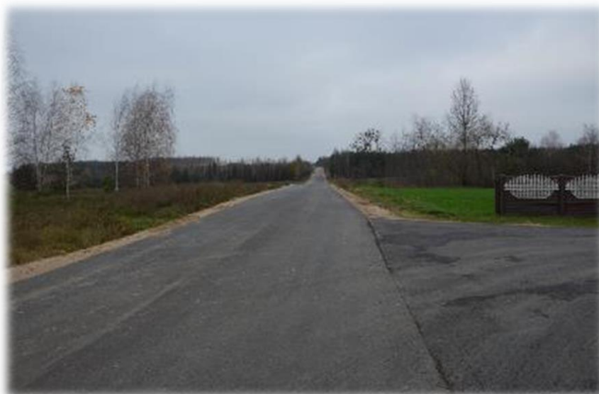
Fot. Modernizacja drogi gminnej ul. Lubowidzka
