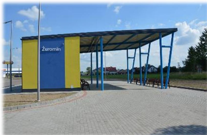
Fot. Budowa mini dworca autobusowego w Żurominie
