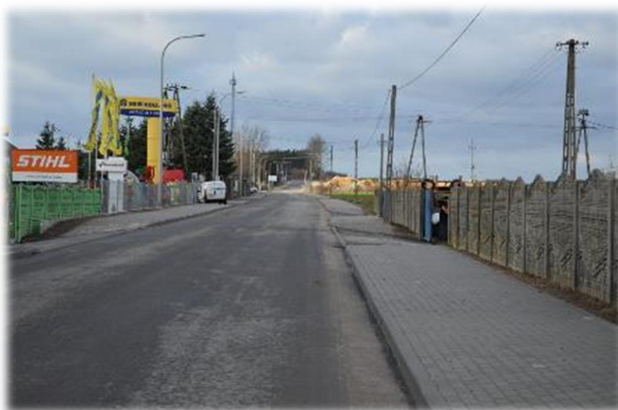
Fot. Przebudowa ulicy Towarowej w Żurominie
