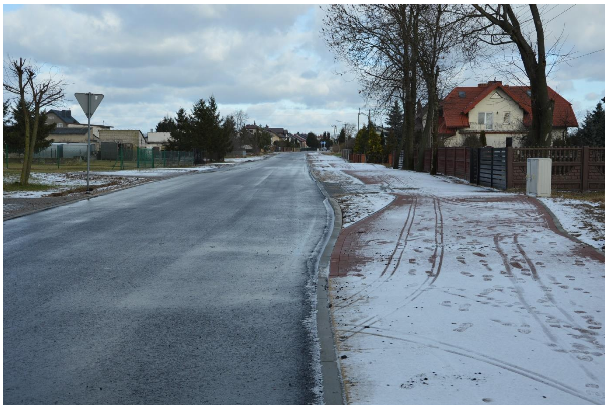
Fot. Przebudowana ul. Pileckiego w Poniatowie
