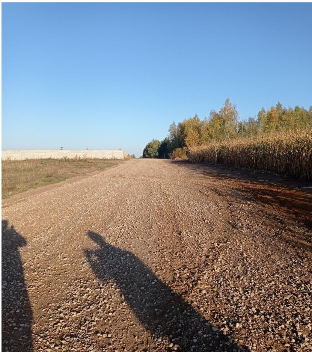
Fot. Przebudowa drogi gminnej ul. Lubowidzkiej w Brudnicach i Wiadrowie
