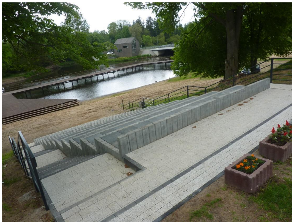
Fot. Widok pomostu i schodów betonowych zrealizowanych w ramach inwestycji pn. „Zagospodarowania przestrzeni publicznej kąpieliska wraz z infrastrukturą, rzeka Wkra w miejscowości Brudnice”
