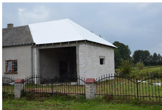
Fot. Wykonanie więźby dachowej i pokrycia dachowego na rozbudowanej części budynku świetlicy wiejskiej o pomieszczenie garażowe w Młudzynie
