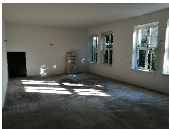
Fot. Zagospodarowanie terenu oraz remont świetlicy wiejskiej w sołectwie Brudnice
