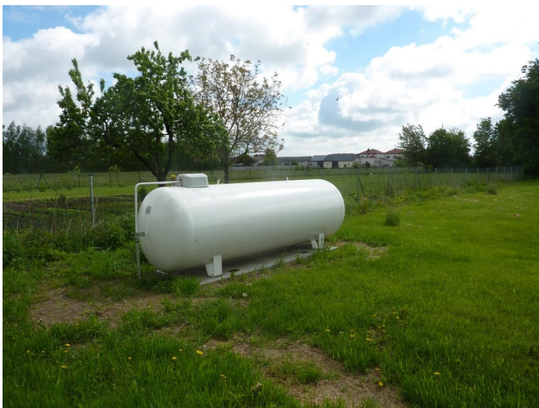
Budowa instalacji gazowej w budynku Szkoły podstawowej w Chamsku wraz ze zbiornikiem oraz przystosowanie kotłowni
