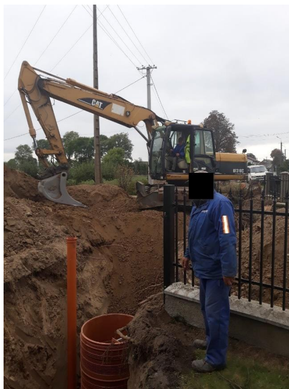
Budowa kanalizacji sanitarnej w Dąbrowie
