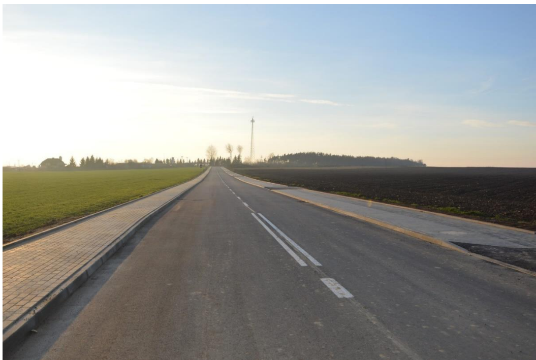
Przebudowa ulicy Strzeleckiej w Żurominie
