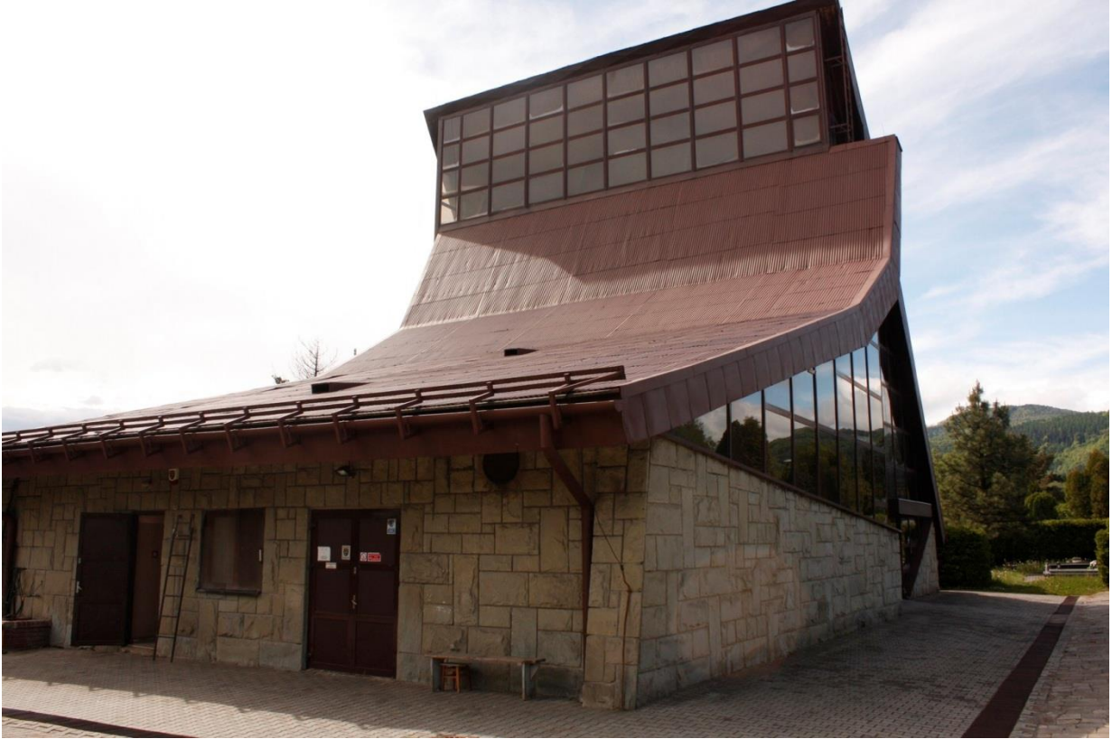
Zdjęcie nr 1 – widok elewacji północnej i zachodniej
