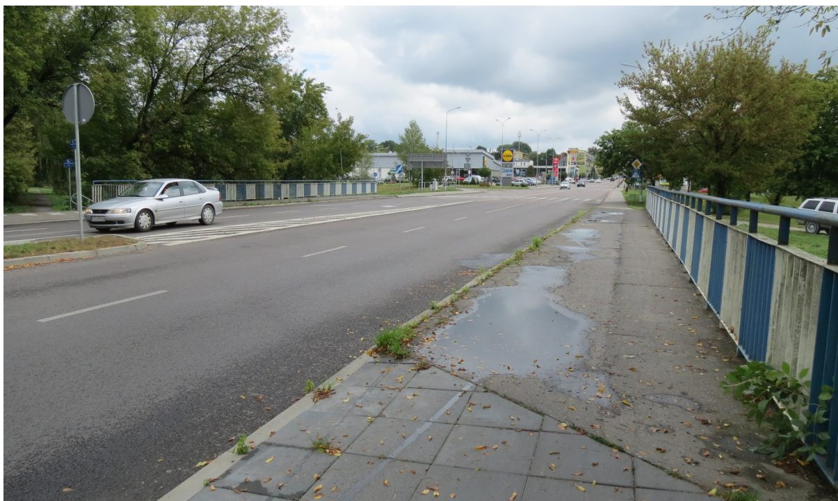
Fot. 4 Widok mostu od strony ul. Dzieci Zamojszczyzny.
