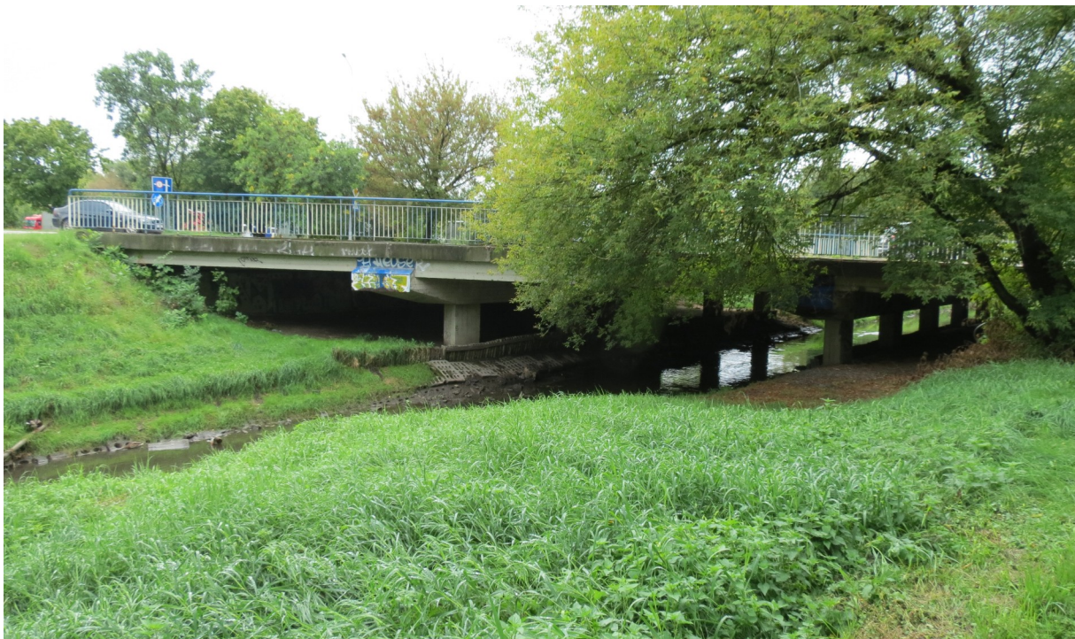
Fot. 1 Widok mostu od strony dolnej wody
