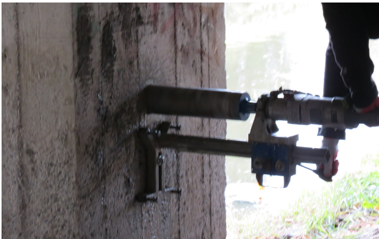
Fot. 40. Pobieranie rdzeni z przyczółka od str. ul. Peowiaków.
