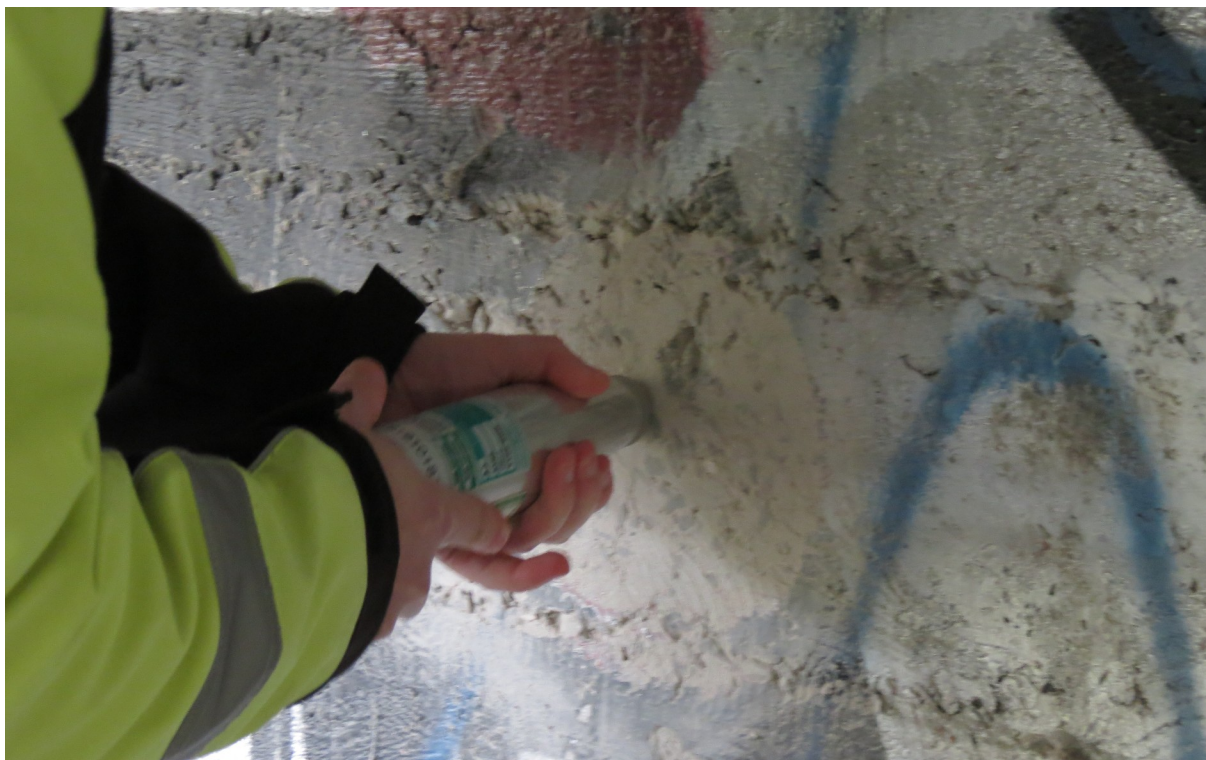
Fot. 47. Nieniszczące badanie betonu młotkiem Schmidta.
