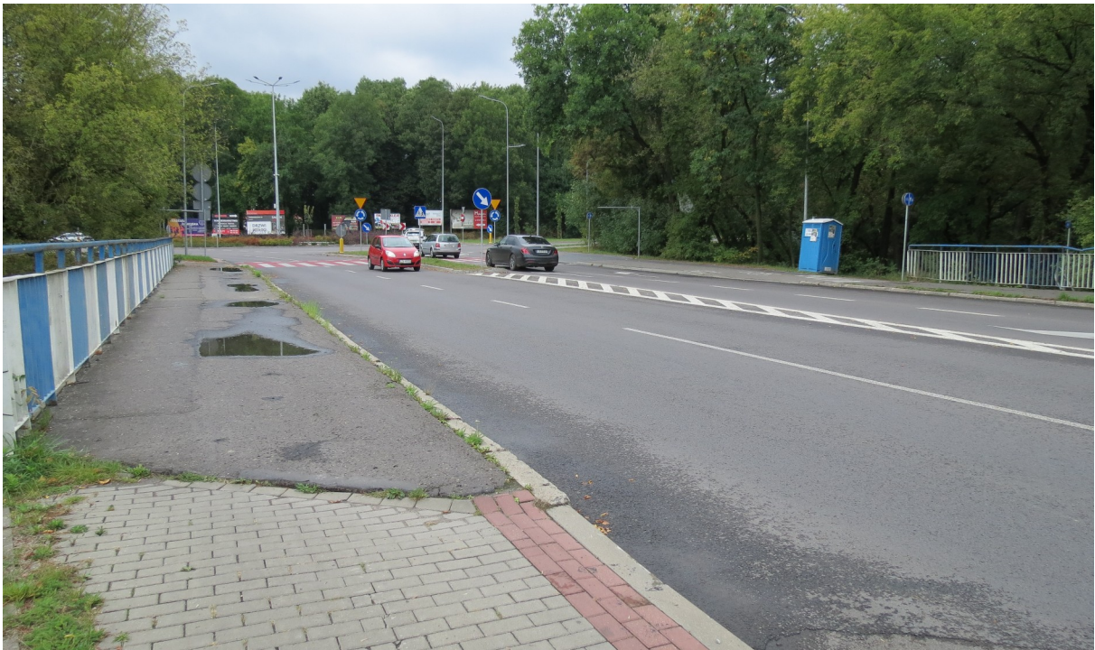
Fot. 3 Widok mostu od strony ul. Peowiaków.
