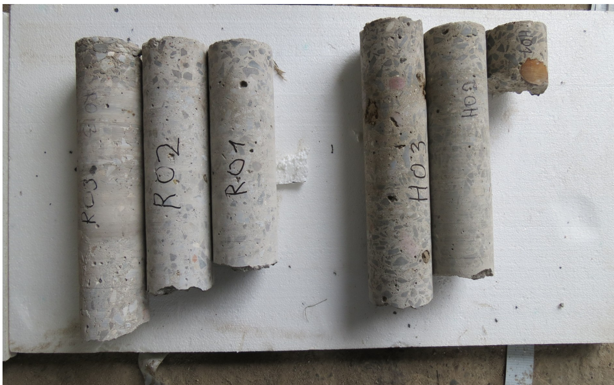
Fot. 43. Widok pobranych rdzenie z oczepów.
