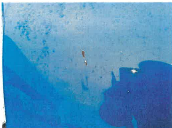
Pokrywa komory silnika - odprysk z korozją.
