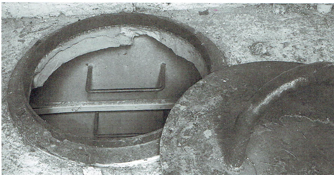
Fot.2 Zejście do komory przejściowej zbiornika
