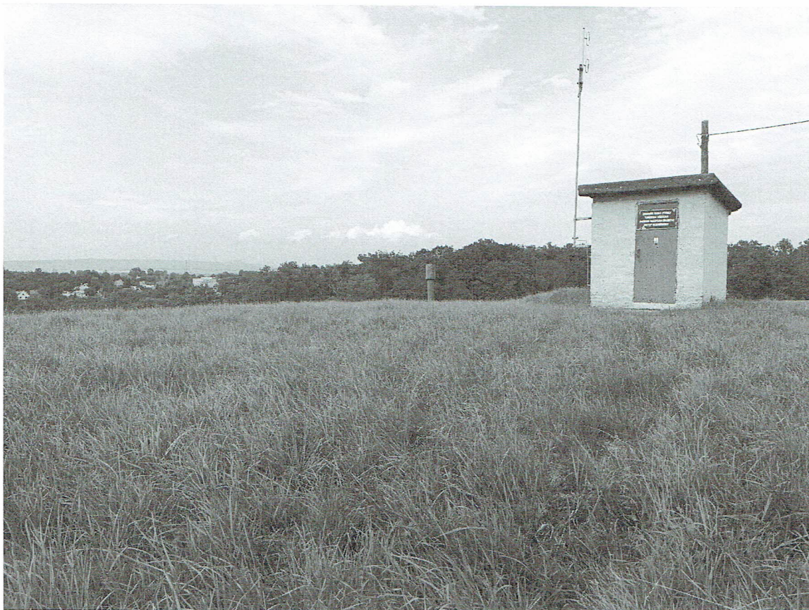
Fot. 1 Zejście do zbiornika – osłona zewnętrzna wejścia
