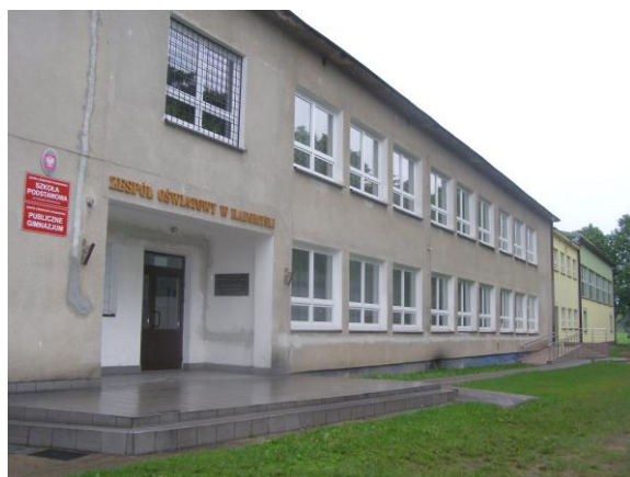
Fot. 11. Budynek szkoły w 2006r. (fot. własna)
