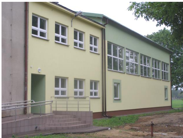
Fot. 12. Nowa część budynku szkoły. (fot. własna)
