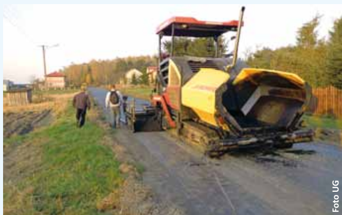
Remont drogi w Borkach-Soldach
