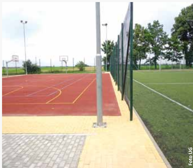
Utwardzenie terenu przy Orliku
