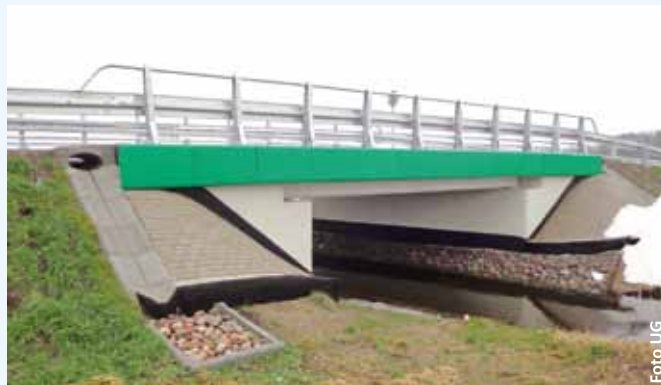
Remont mostu w Ciosnach
