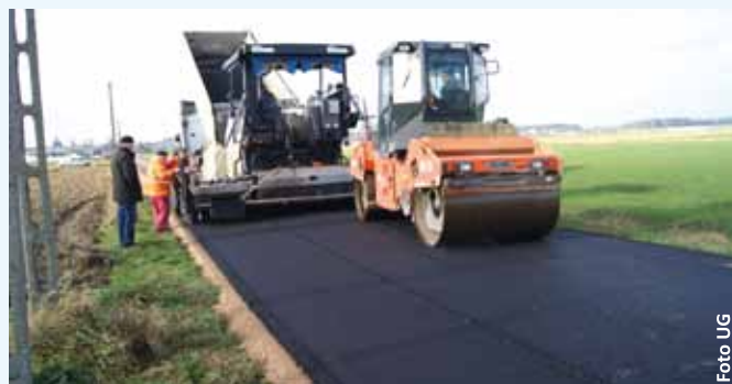
Budowa drogi w Radomyśli
