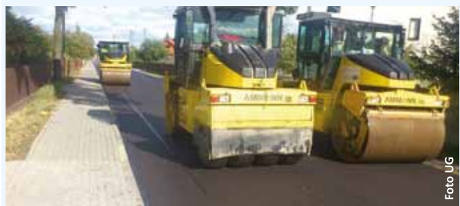
Przebudowa drogi Mościbrody-Zbuczyn
