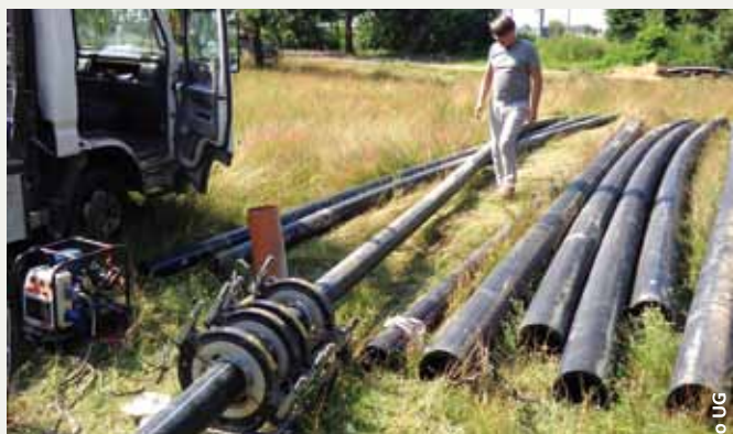
Budowa wodociągu Mościbrody- Helenów
