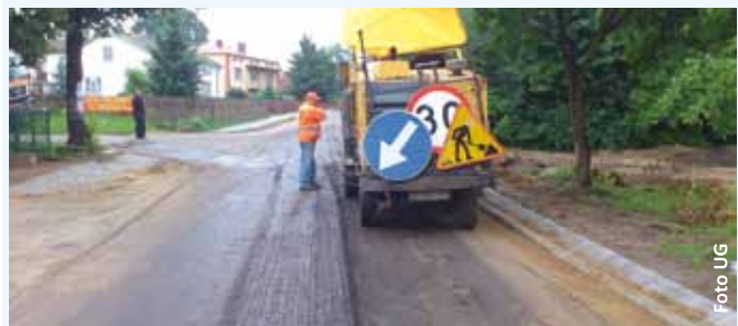
Przebudowa drogi Mościbrody- Zbuczyn
