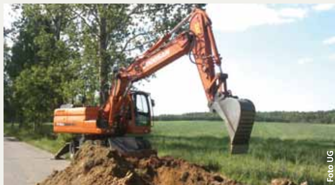
Budowa wodociągu w Stoku Wiśniewskim
