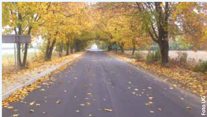
Chodnik przy drodze powiatowej
