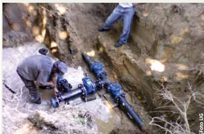
Budowa wodociągu Wiśniew- Wiśniew Kol.
