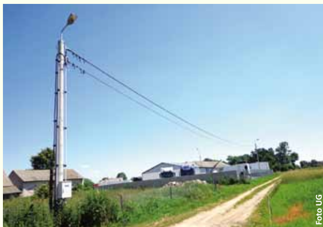
Budowa oświetlenia, Wiśniew, ul. Południowa
