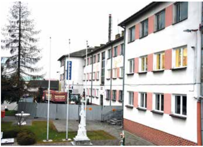
Urząd Gminy rozpoczęcie prac fot. UG
