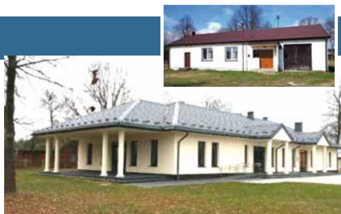
Świetlica w Tworkach przed. Fot. UG.
