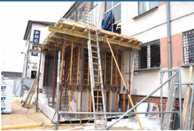
Urząd Gminy w trakcie modernizacji. Fot UG
