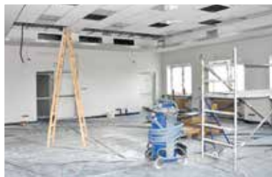
Remontowane drugie piętro Urzędu Gminy Wiśniew. Fot. UG
