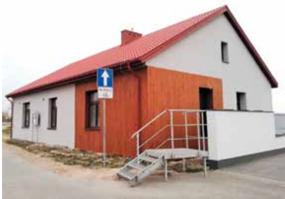
Wyremontowana świetlica w miejscowości Wiśniew-Kolonia. Fot. UG
