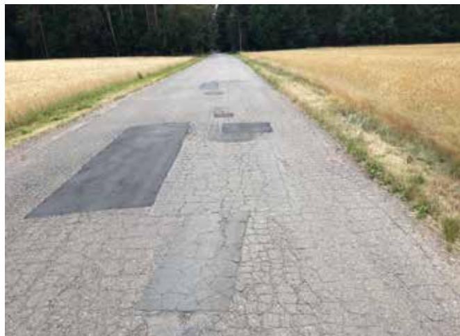
Usunięte ubytki w nawierzchni na drogach gminnych. Fot. UG
