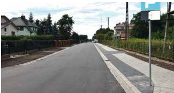
Ulica Sanitariuszek po przebudowie. Fot. UG
