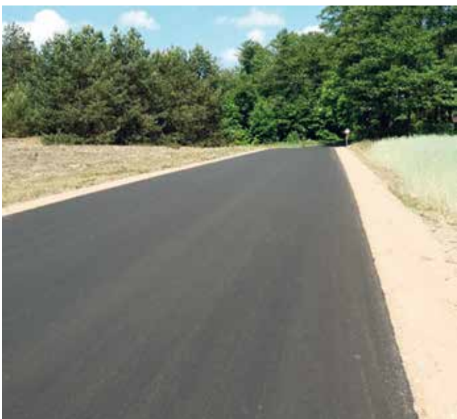
Droga gminna Myrcha – Wólka Wołyńska po przebudowie. Fot. UG
