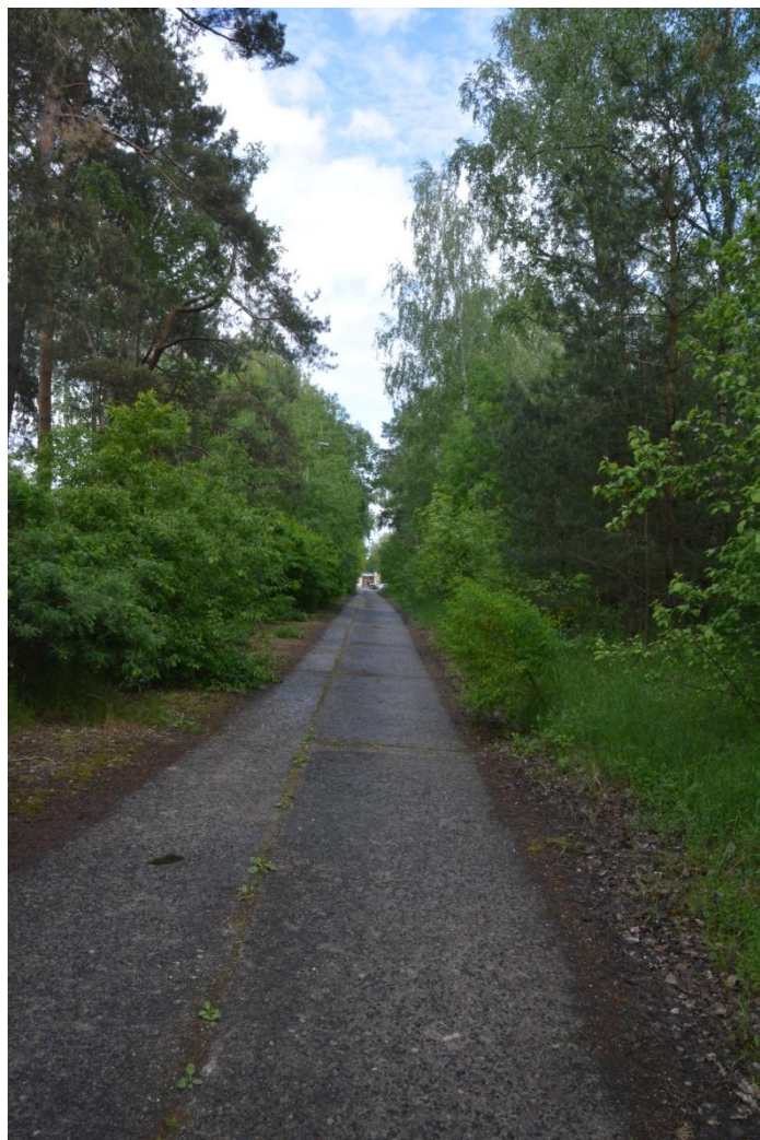
Ryc. 2. Widok fragmentu drogi. Po lewej stronie znajduje się teren ciepłowni.
