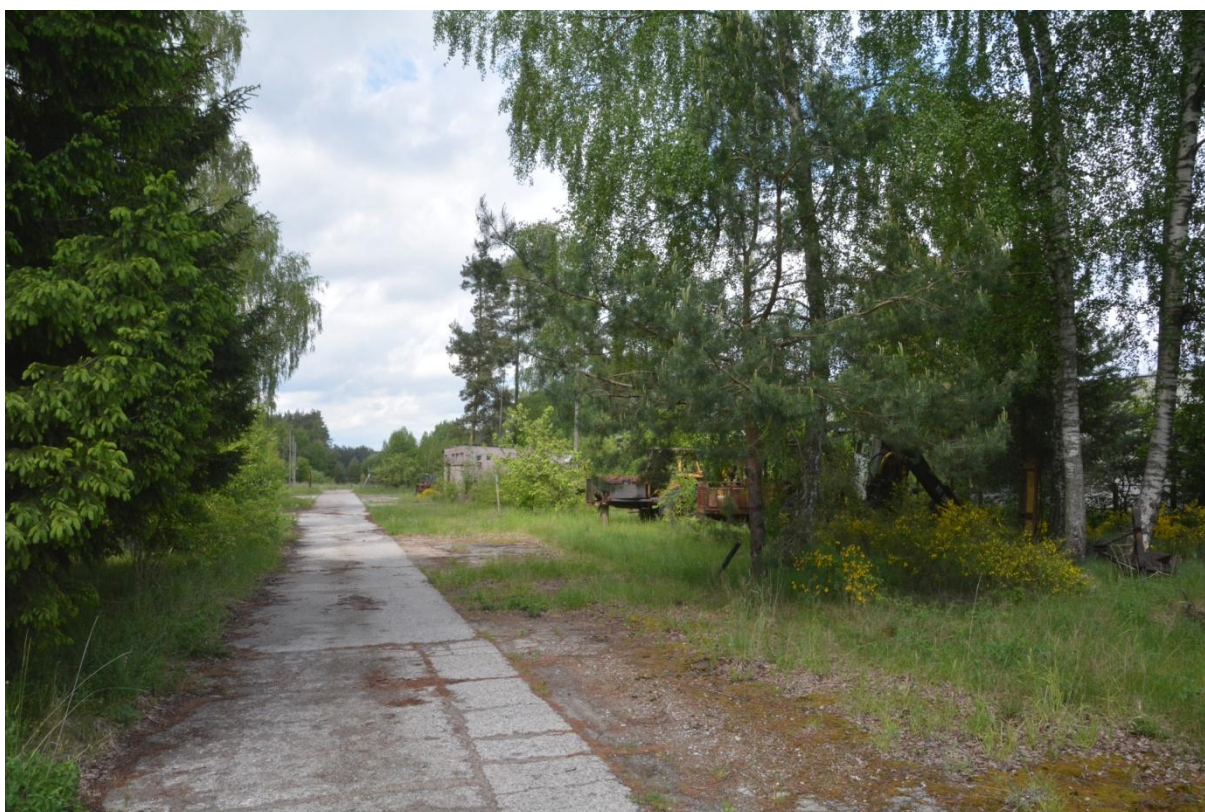
Ryc. 4. Drogi dojazdowe oraz utwardzone place powoli zarastające roślinnością.
