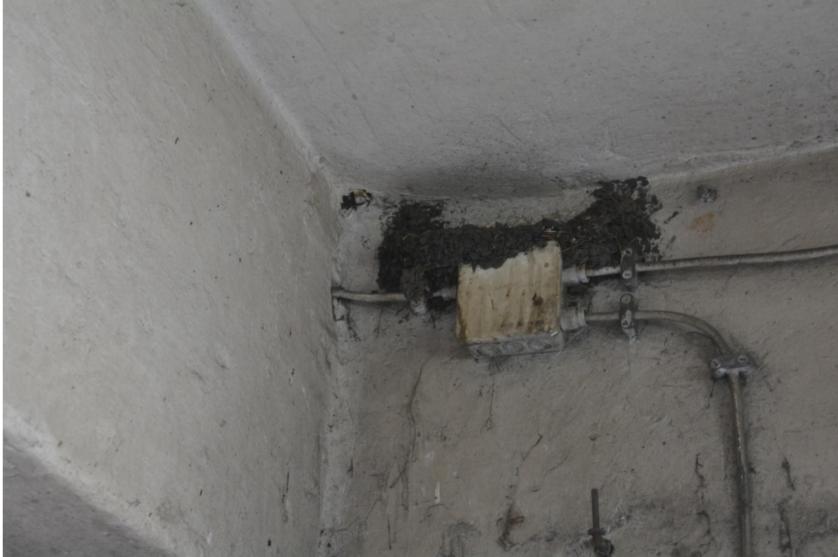
Ryc. 5. Gniazdo dymówki wewnątrz budynku ciepłowni w trakcie budowy.
