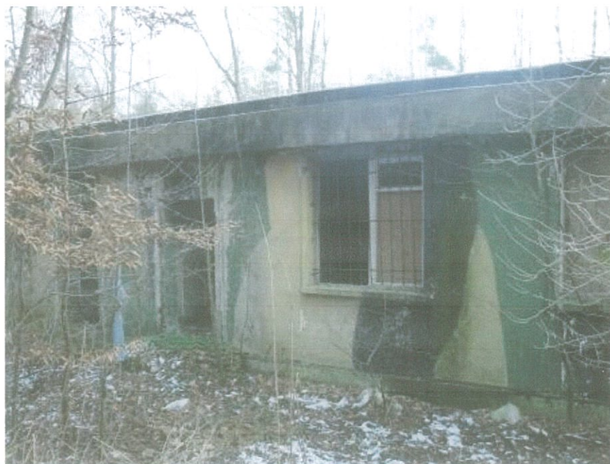
Elewacja zachodnia budynku - fragment.
