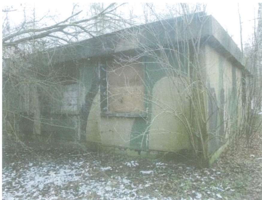
Elewacja zachodnia budynku - narożnik południowo-zachodni.
