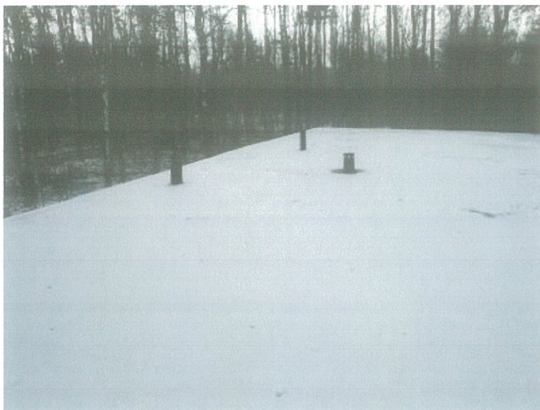
Aktualizacja. Dach części południowej - fragment. połąć, kominki wentylacji grawitacyjnej sanitariatów i umywalni.
