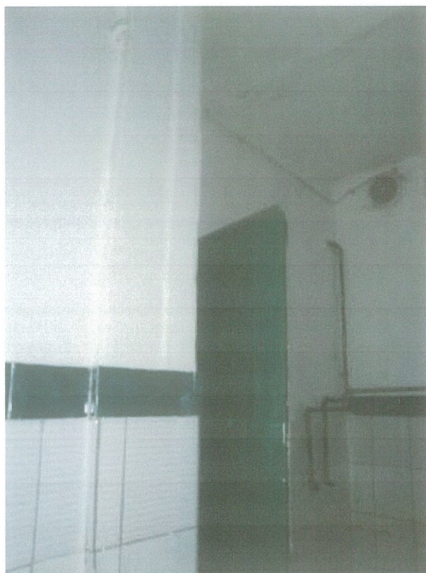
Sanitariaty. Widoczne ściany, skrzydła drzwiowe, wentylator elektryczny, okładzina ceramiczna ścian, fragmenty instalacji wody. Stan techniczny pomieszczenia średni.
