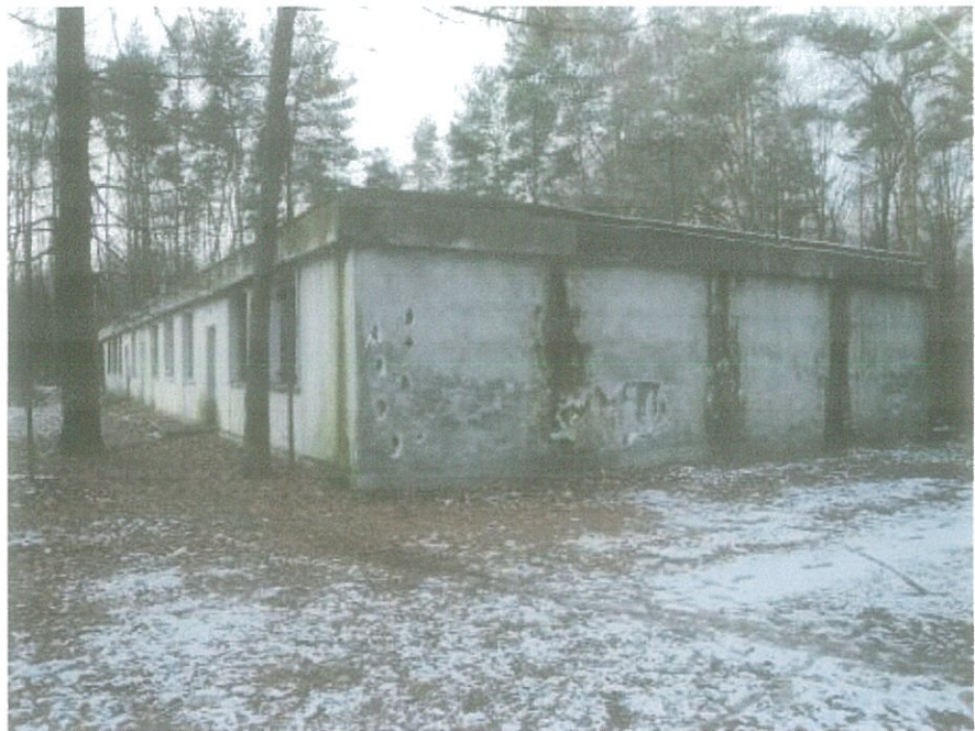
Narożnik północno-wschodni budynku.
