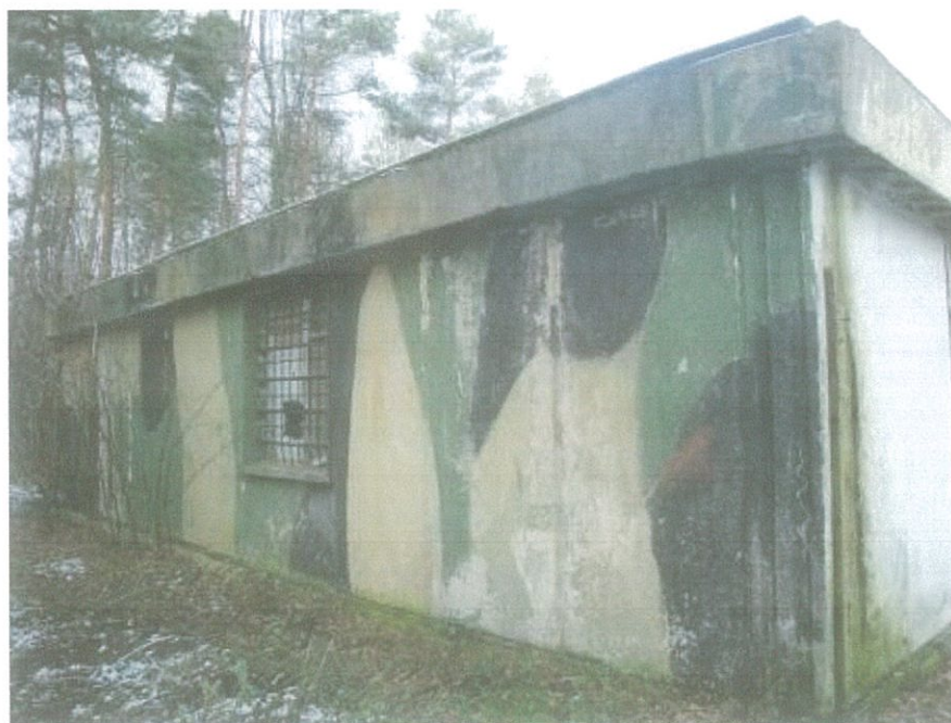
Elewacja południowa /narożnik południowo-wschodni.
