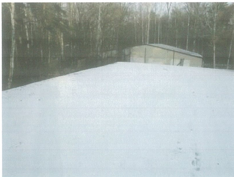
Aktualizacja. Dach części północnej - fragment.
