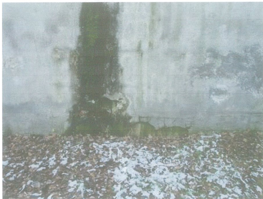
Elewacja północna budynku.
