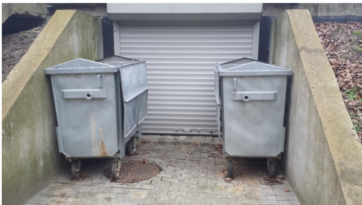
Rysunek 10 Widok kontenerów na skratki [13] umieszczonych we wnęce przy reaktorze biologicznym SBR [5]
