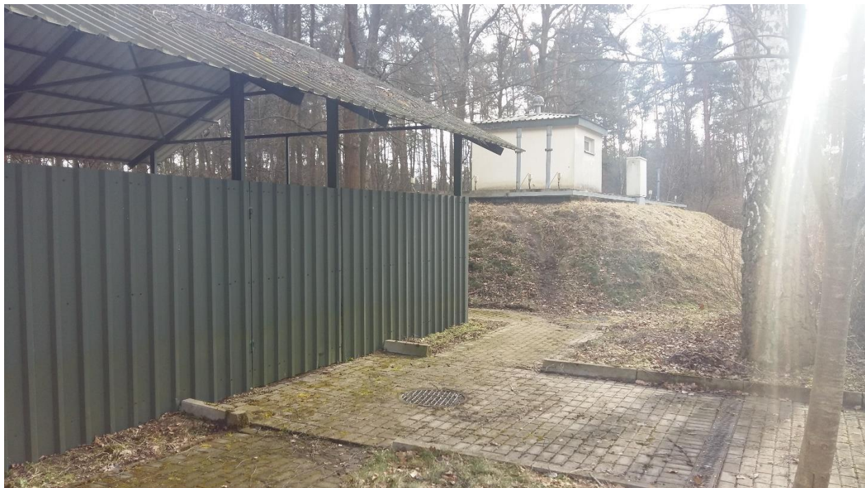
Rysunek 5 Widok ogólny na teren oczyszczalni od strony wejściowej
