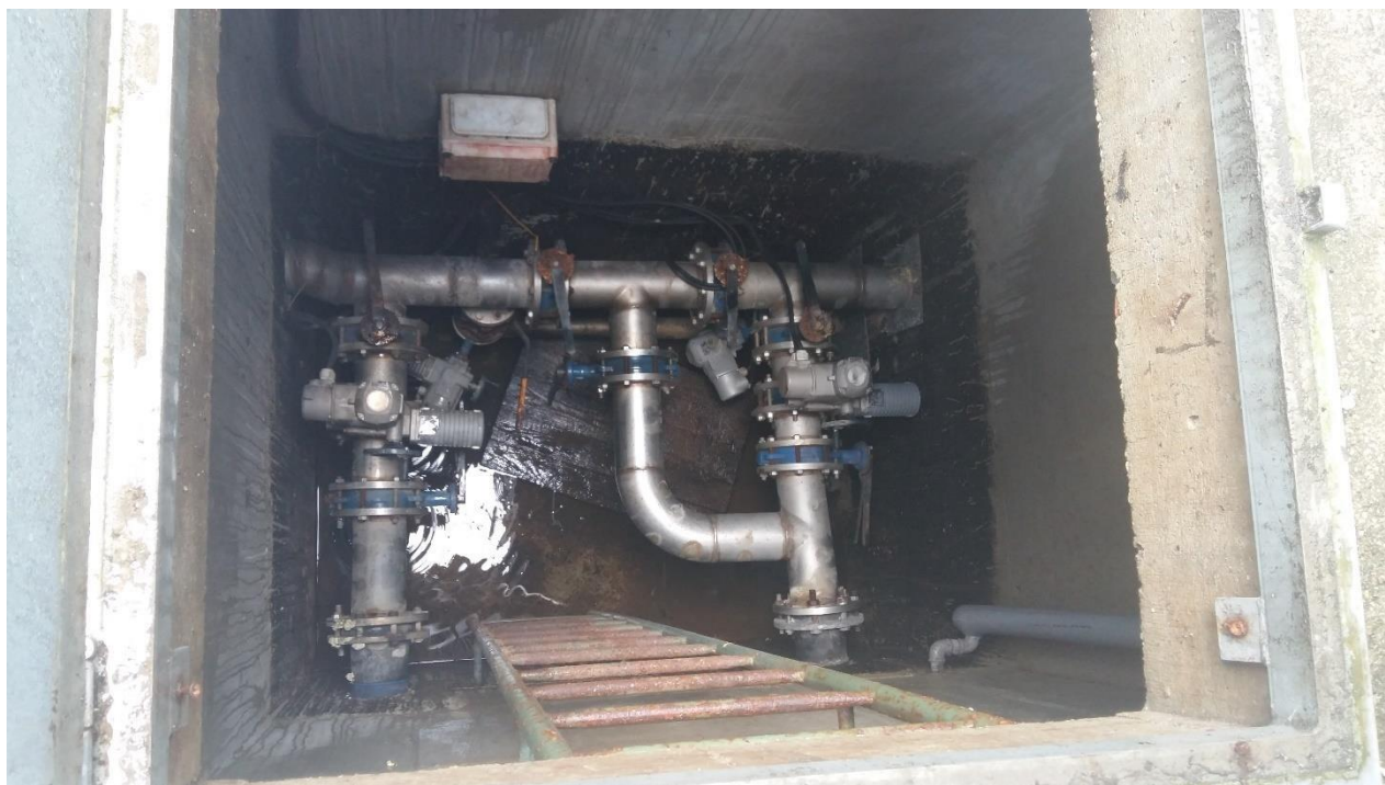
Rysunek 17 Widok wnętrza komory wylotowej (spustowej)
