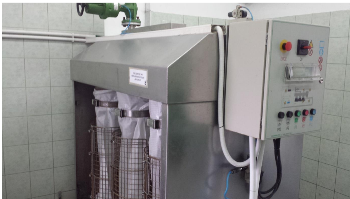
Rysunek 26 Widok workownicy DRAIMAD firmy EKOFINN w budynku odwadniania osadów [9]
