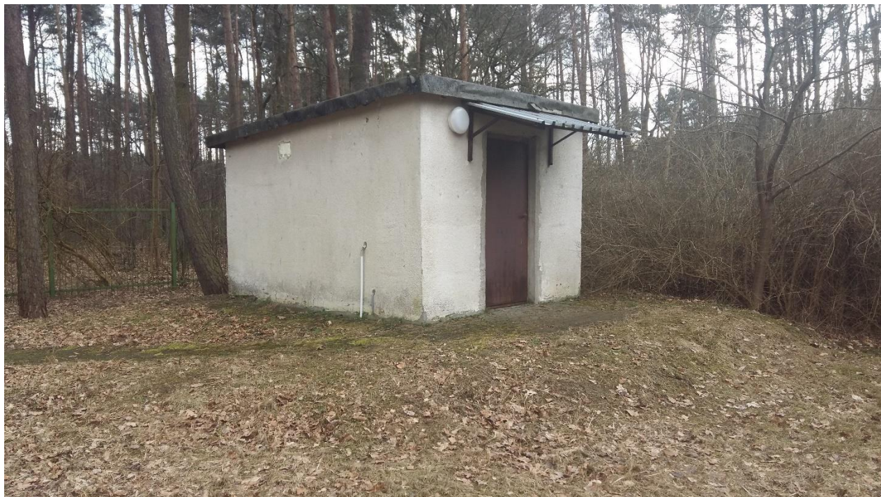
Rysunek 22 Widok ogólny budynku pompowni ścieków oczyszczonych
