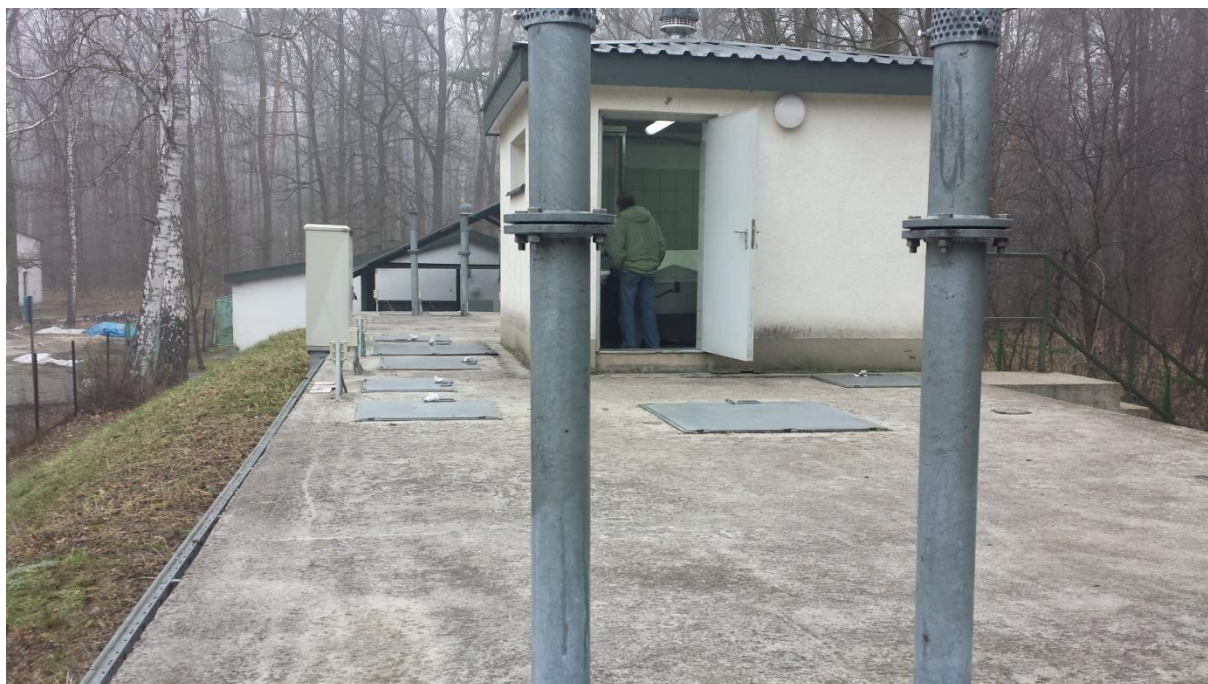
Rysunek 9 Widok pomieszczenia sita bębnowego [3] zlokalizowanego na reaktorze biologicznym typu SBR [5]
