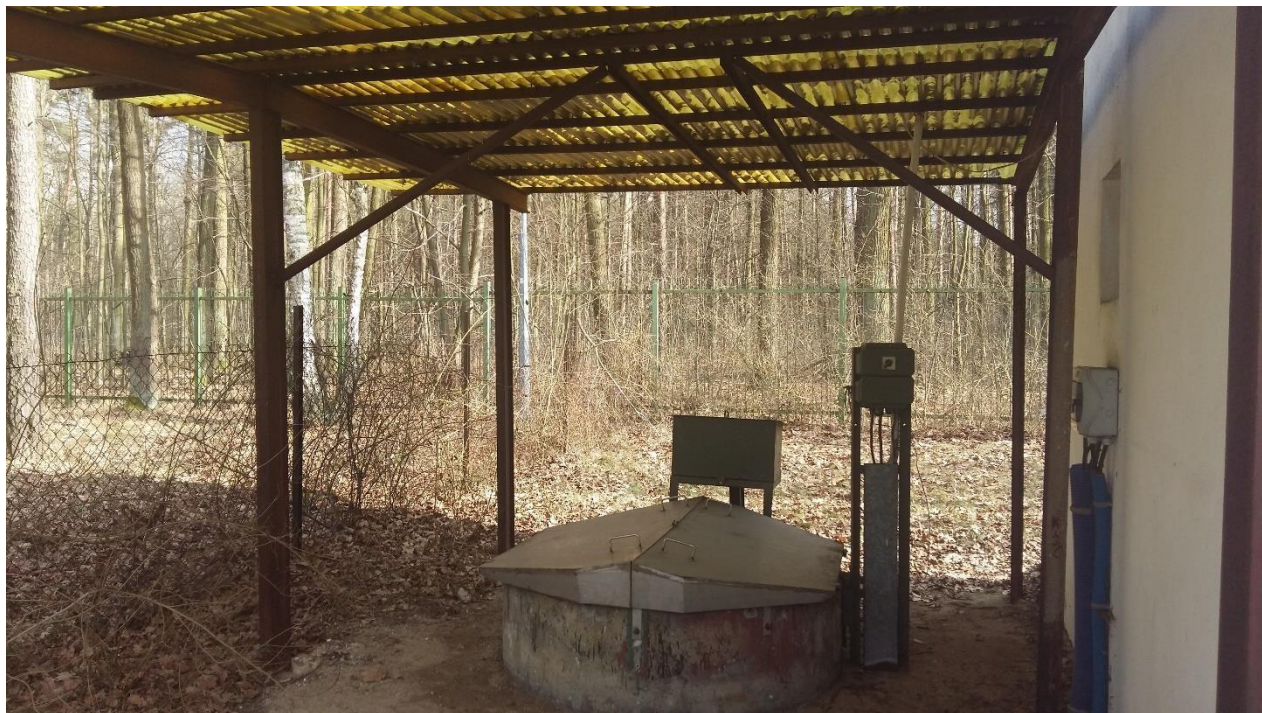
Rysunek 8 Zadaszenie (wiata) [12] pompowni ścieków surowych [2]
