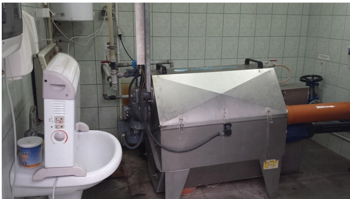
Rysunek 13 Widok części mechanicznej OŚ „DĘBAK” wraz z sitem bębnowym umieszczonym w pomieszczeniu [3]
