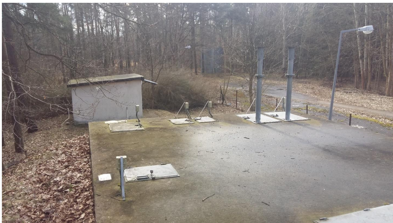
Rysunek 14 Widok górnej części reaktora biologicznego typu SBR [5]
