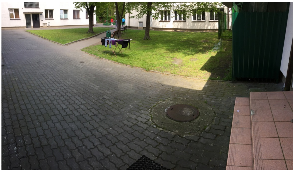
Foto. 3.1.2 Ciąg pieszy, widok z punktu włączenia instalacji co. do istniejącego węzła
