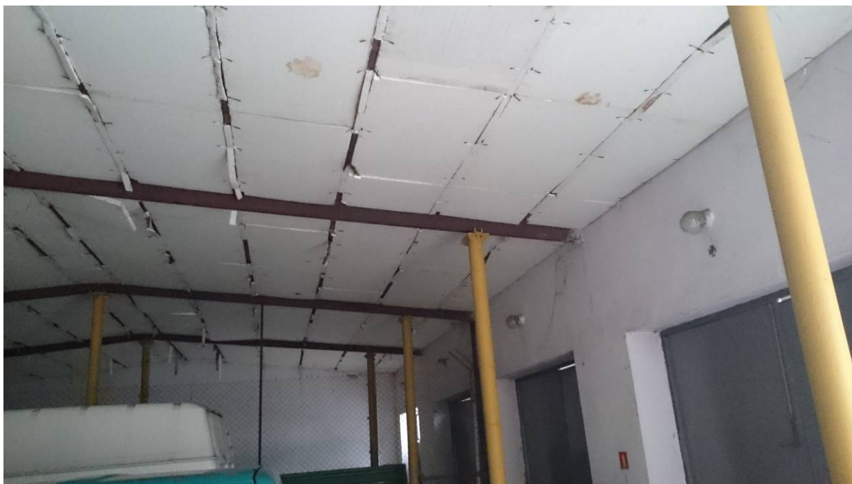
Zdjęcie nr 05 – Ramy poprzeczne.
