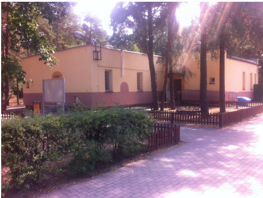
fot. 7.1.2 Budynek nr 42 PORTIERNIA, widok od strony ośrodka
