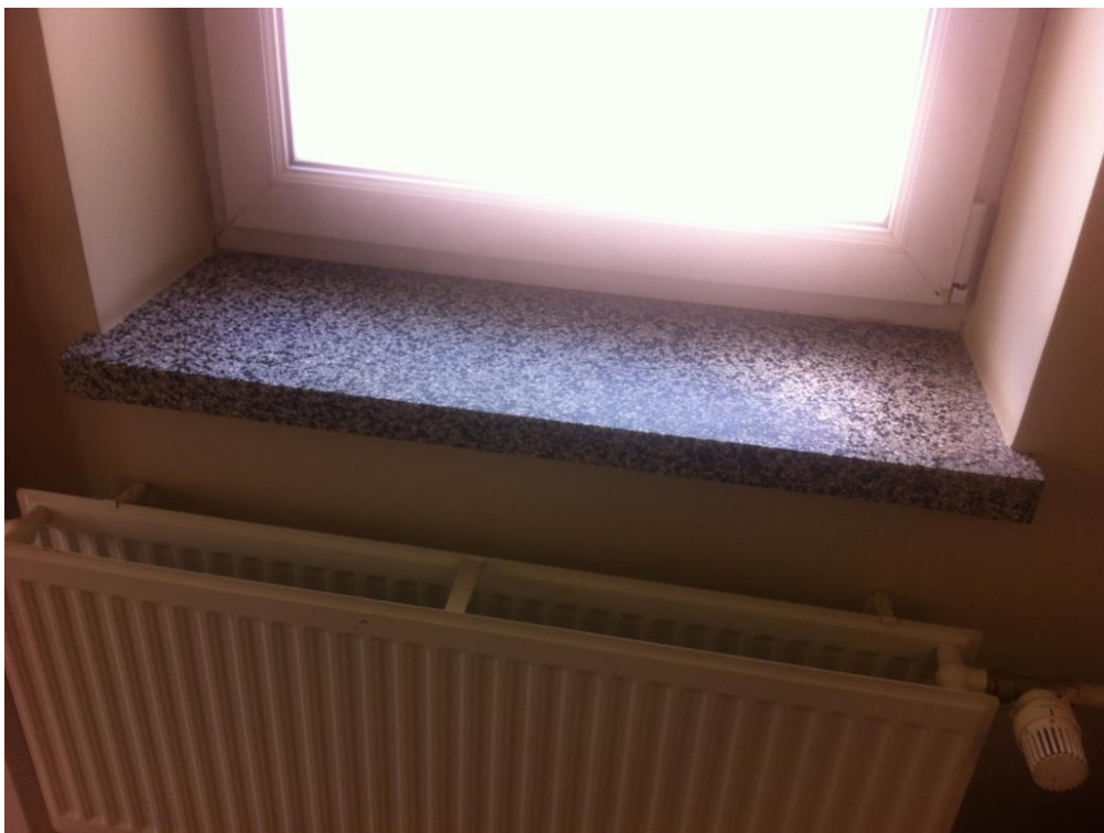
fot. 8.2.3 budynek nr 26 – parapet wykonany z lastryko wykonany z dużą precyzją
