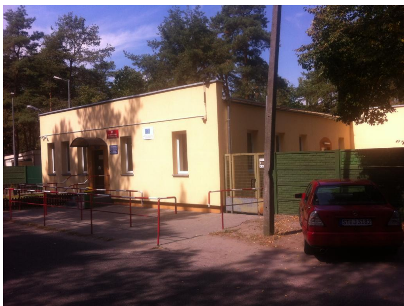
fot. 7.1.1 Budynek nr 42 PORTIERNIA, widok od stron drogi dojazdowej
