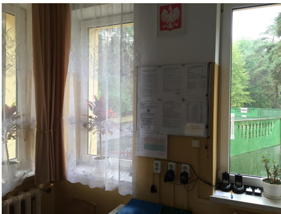
fot. 7.1.4 Okna w pomieszczeniu ochrony – filar międzyokienny ogranicza pole obserwacji strefy wjazdowej
