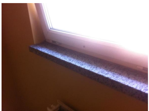
fot. 4.2.1.7 parapety oryginalne wykonane z lastryko w bardzo dobrym stanie
