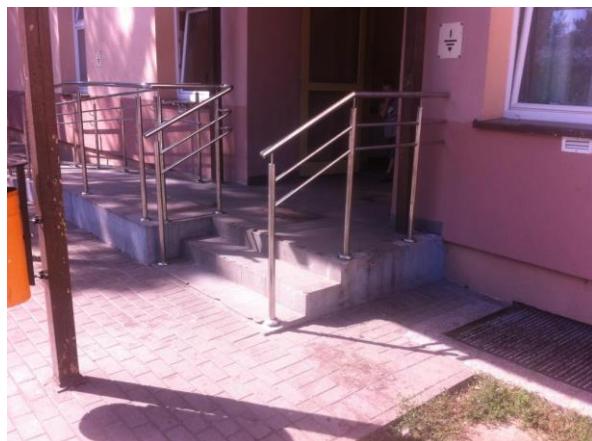
fot. 4.2.1.13 Podest wejściowy i rampa dla osób poruszających się na wózkach: zdegradowana okładzina
