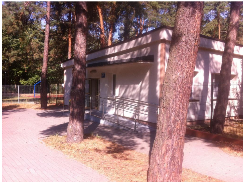
fot.8.1.1 budynek nr 26 – widok na skrzydło ambulatoryjne
