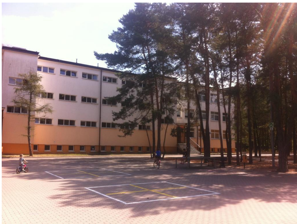
fot.5.1.1 budynek nr 29 – elewacja frontowa skrzydło południowe
