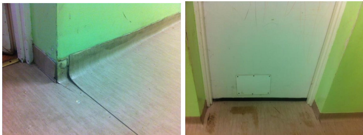
fot.4.2.1.1 Znaczny stopień zużycia wykładziny PVC, odklejanie się skrajnych płaszczyzn
