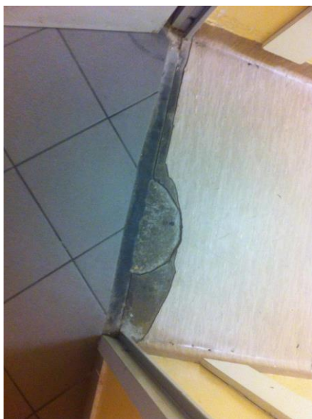
fot. 4.2.1.2 Degradacja miejsc łączenia płytek gresowych (klatka schodowa) z wykładziną PVC (korytarze)
