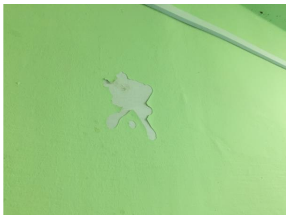
fot. 5.2.1.4 Zdegradowane nawierzchnie ściennie na przestrzeniach korytarzowych.
