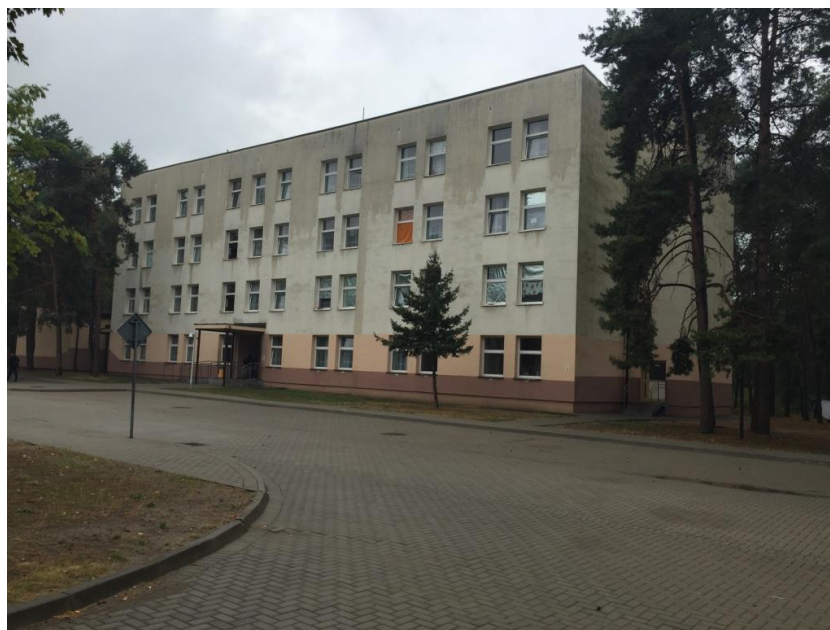
Fot. 4.1 Elewacja frontowa budynku hotelowego nr 30
