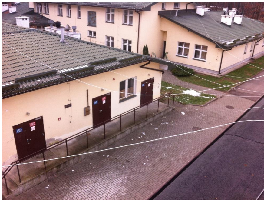
Foto. Nieuporządkowana sieć przewodów teletechnicznych pomiędzy budynkami
