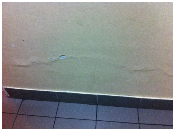
Foto. Ściany na poziomie przyziemia we wnętrzach Hotelu Nowego – widoczna degradacja w wyniku działania wilgoci
