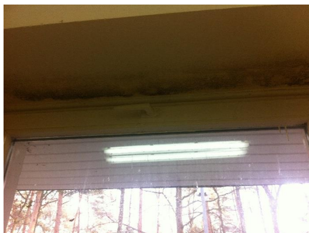
Foto. Widoczne zagrzybienia powstałe m.in. w wyniku nadmiernej wilgoci i niedostatecznej wentylacji
