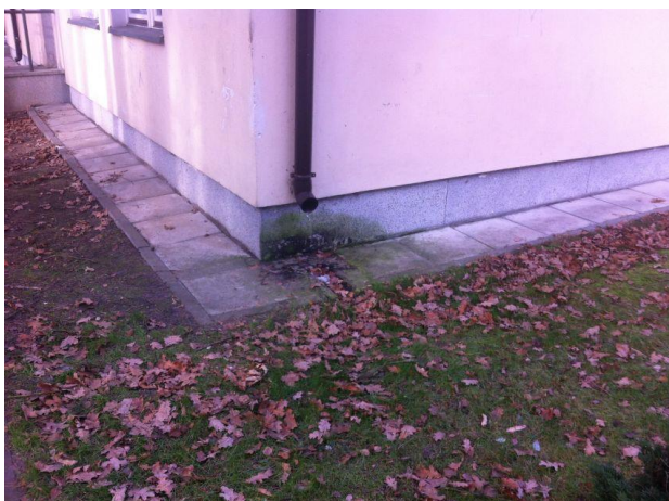
Foto. Niewłaściwie zakończona rura spustowa powoduje zalewanie wodą opaski wokół bud., powodując powstawanie wykwitów na opasce oraz przedostawanie się wody do ścian fundamentowych
