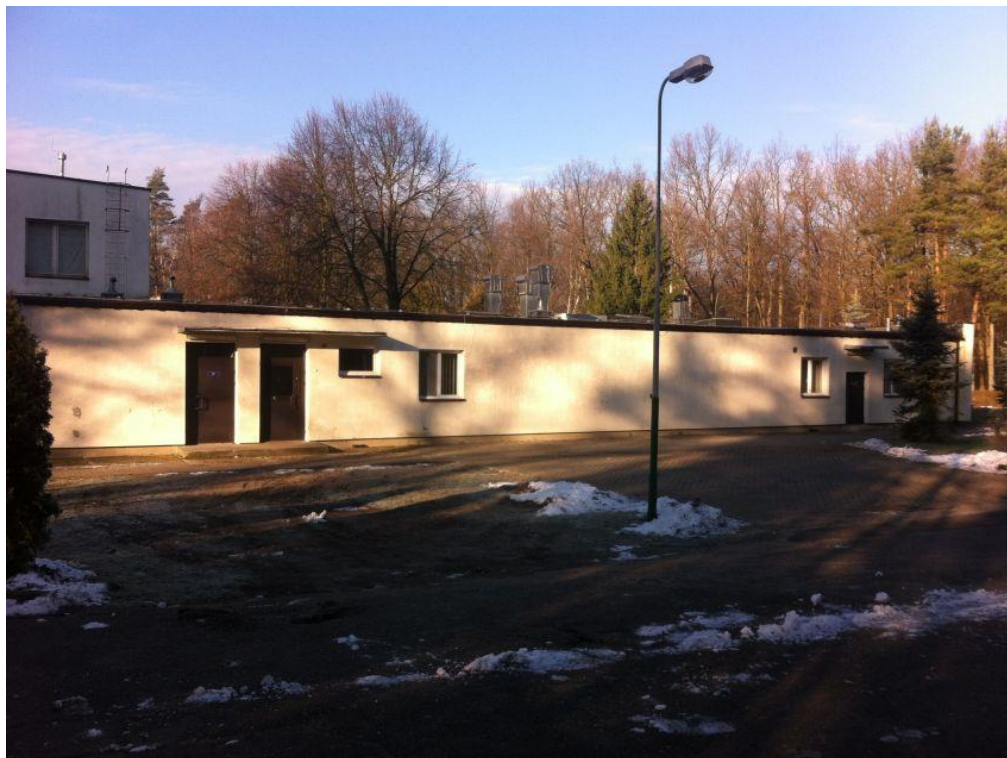
Foto.1 blok C Hotelu Starego, na pierwszym planie widoczna latarnia oświetleniowa
