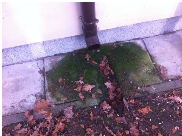
Foto. Niewłaściwie zakończona rura spustowa powoduje zalewanie wodą opaski wokół bud., powodując powstawanie wykwitów na opasce oraz przedostawanie się wody do ścian fundamentowych
