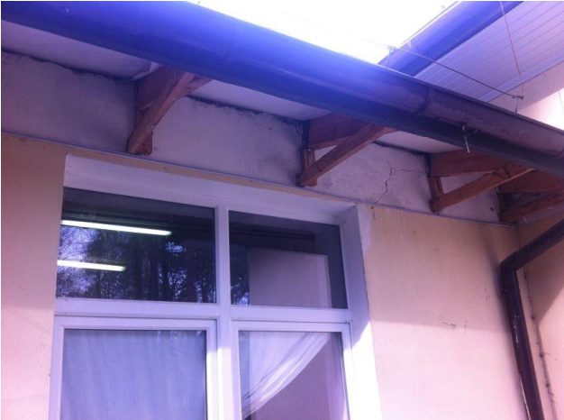
Foto. Podbitka dachowa – widoczne uszkodzenia, prześwity, a także miejscowo całkowity brak
