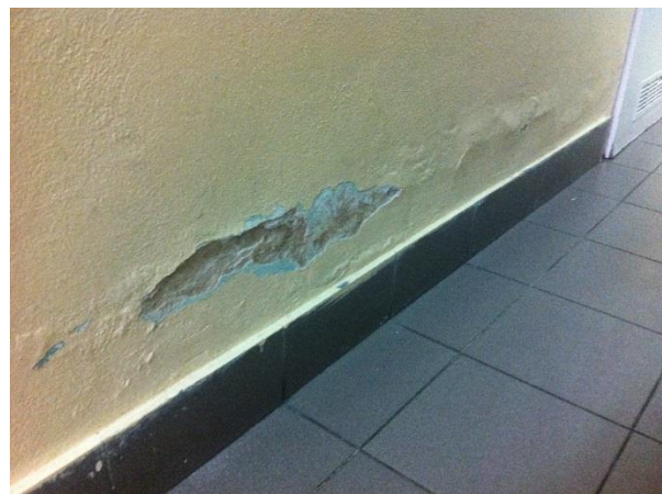
Foto. Ściany na poziomie przyziemia we wnętrzach Hotelu Nowego – widoczna degradacja w wyniku działania wilgoci
