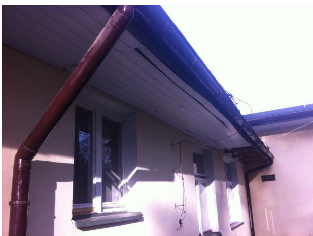
Foto. Podbitka dachowa – widoczne uszkodzenia, prześwity, a także miejscowo całkowity brak
