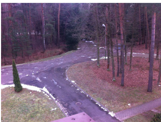
Foto. Drogi wewnętrzne z nawierzchnią bitumiczną
