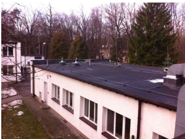
Foto. Blok D – widok z dachu bloku C
