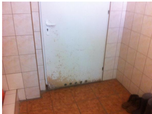
fot. 5.2.1.5 Widoczna dewastacja drzwi wejściowych do pomieszczeń mieszkalnych i sanitarnych.
