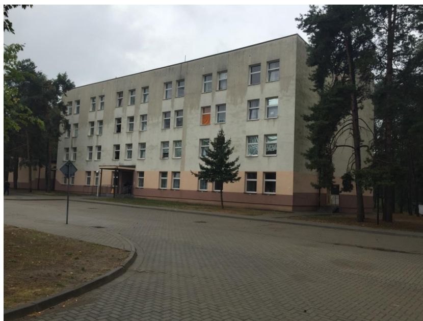
Fot. 3.1.2 Drogi dojazdowe do budynków oraz chodniki wykonane z kostki betonowej
