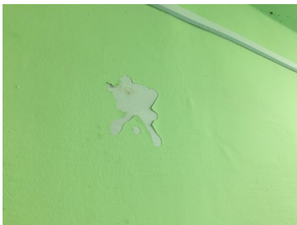
fot. 5.2.1.4 Zdegradowane nawierzchnie ścienne na przestrzeniach korytarzowych.
