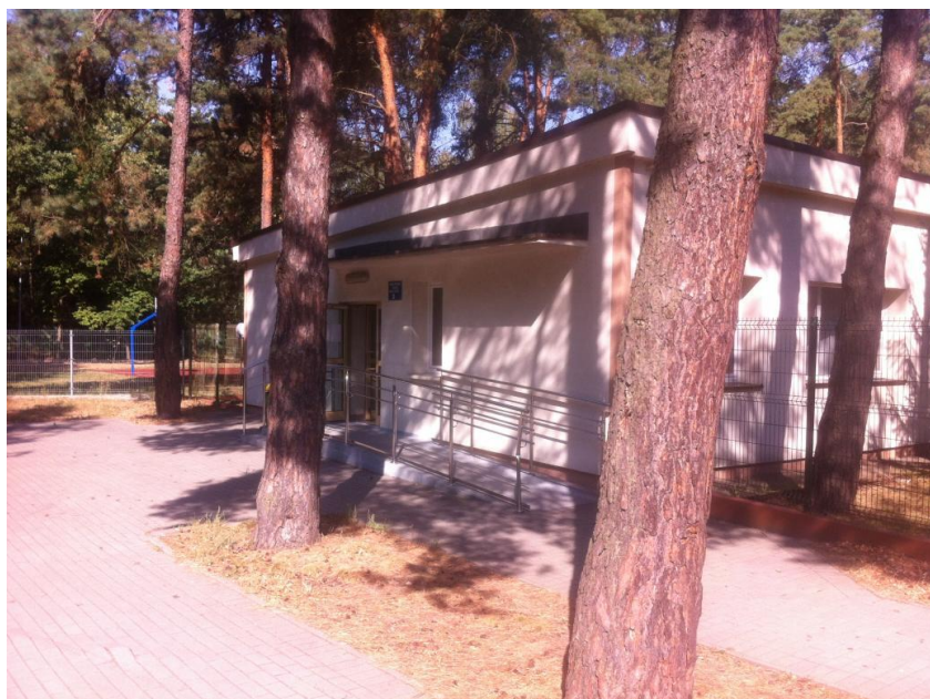
fot.8.1.1 budynek nr 26 – widok na skrzydło ambulatoryjne
