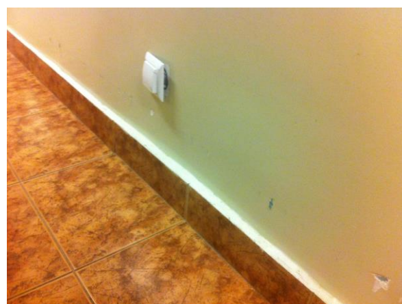
fot. 6.2.3 Widoczne uszkodzenia spowodowane uderzeniami wózka transportowego
