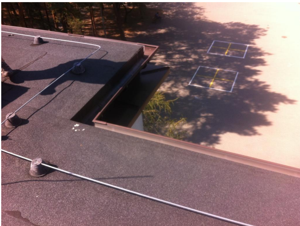
fol. . 5.2.2.4 Dach bud. 29: widoczne rynny z PVC
