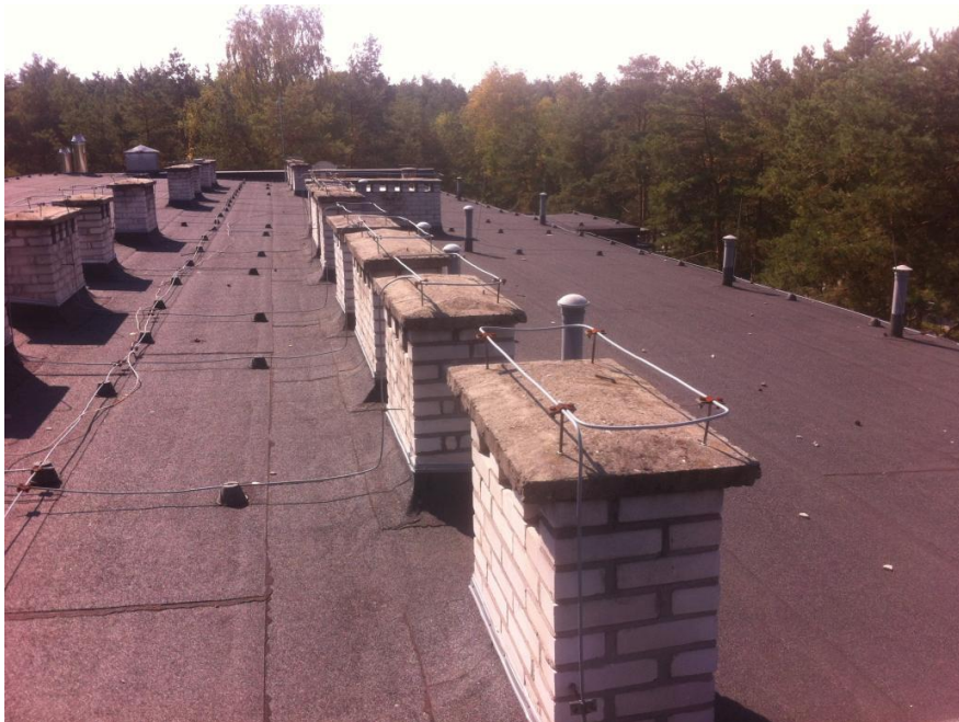
fol. 5.2.1.12 Dach bud. 29 kryty papą, widoczne nieotynkowane kominy wentylacyjne. oraz inst. odgromowa
