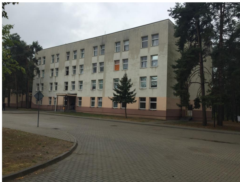
Fot. 4.1 Elewacja frontowa budynku hotelowego nr 30
