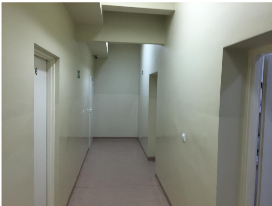
fot. 8.2.5 budynek nr 26 – część ambulatoryjna, widok na ścianę oddzielającą od części administracyjnej
