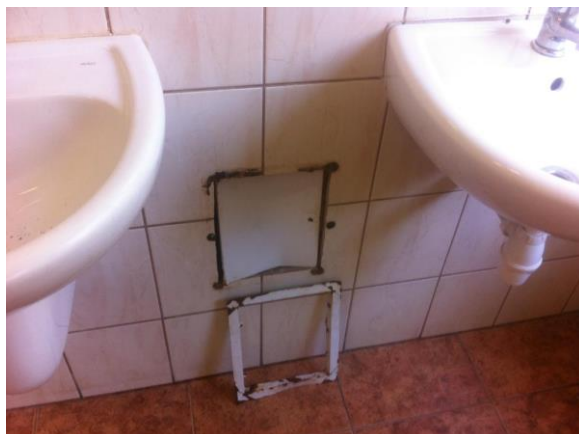
fot. 4.2.1.6 zdewastowane drzwi wejściowe do WC oraz zniszczone drzwiczki rewizyjne pod zlewami.
