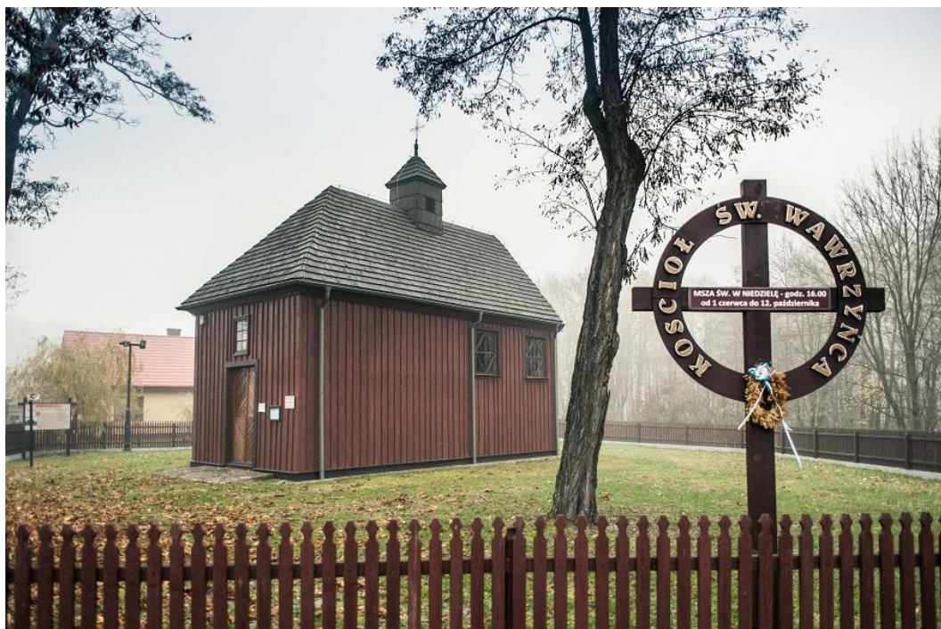
Fot. 7 Kościół pw. św. Wawrzyńca w Bliznie
