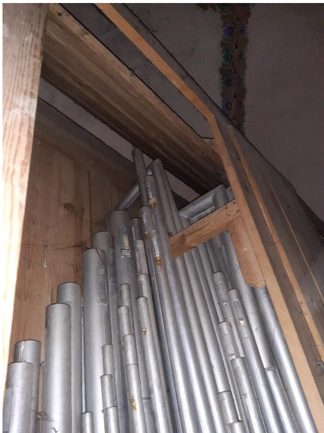
Rysunek 14. Piszczalki II manuatu, umieszczone w szafie ekspresyjnej - brak płyciny od strony kościoła. Na górze widoczna żaluzja.
