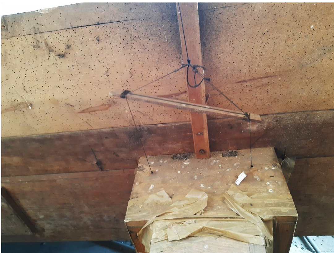
Rysunek 12. Połączenie dmuchawy z miechem. Widoczne liczne ślady działalności drewnojadów oraz niefachowe uszczelnienia kanałów powietrznych.
