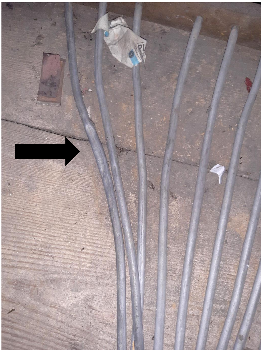
Rysunek 9. Uszkodzone przewody ołowiane rozłożone na podłodze
