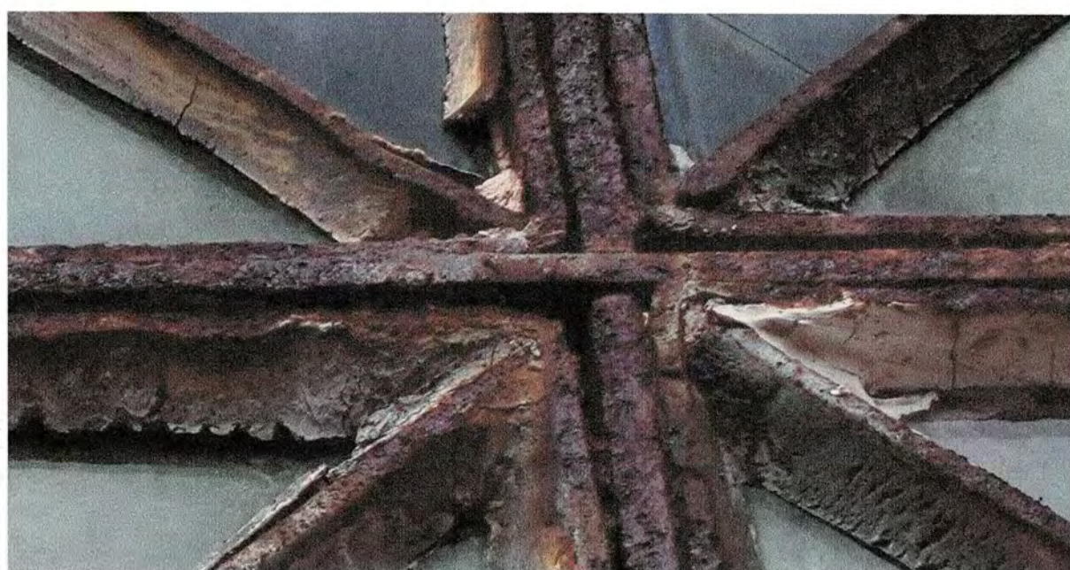
Zdjęcie nr9-10 Odkształcenia profili stalowych spowodowane korozją
