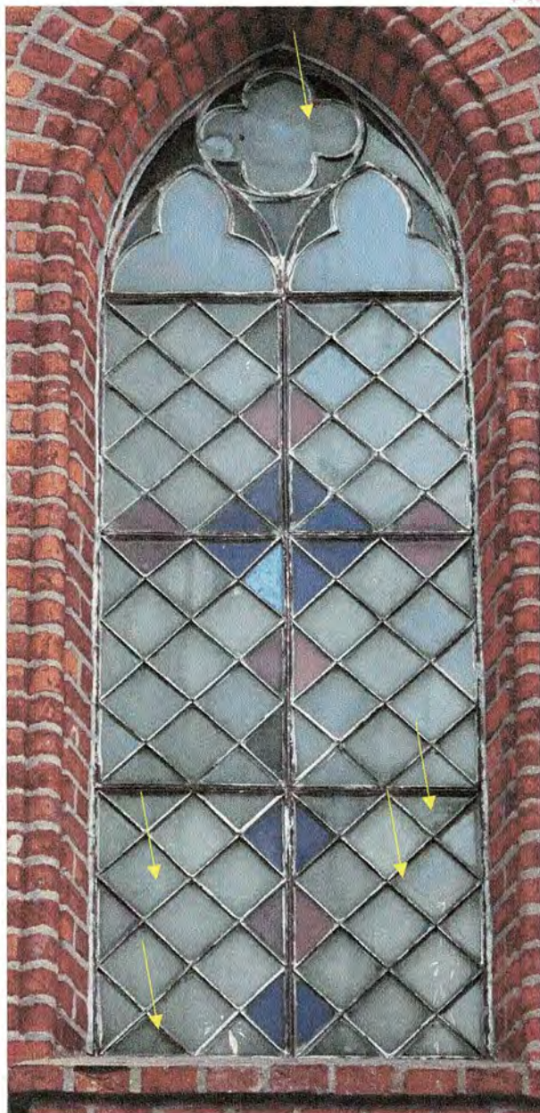
Zdjęcie nr 3. Pęknięcia szyb spowodowane naprężeniami wywoływanymi przez stalowe ramy
