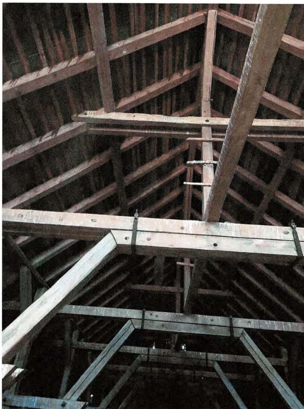
Zdjęcie nr 6. Uszkodzona górna jętka do wzmocnienia
