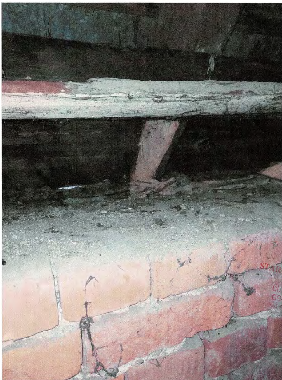
Zdjęcie nr 5. Zniszczony końcowy fragment krokwi
