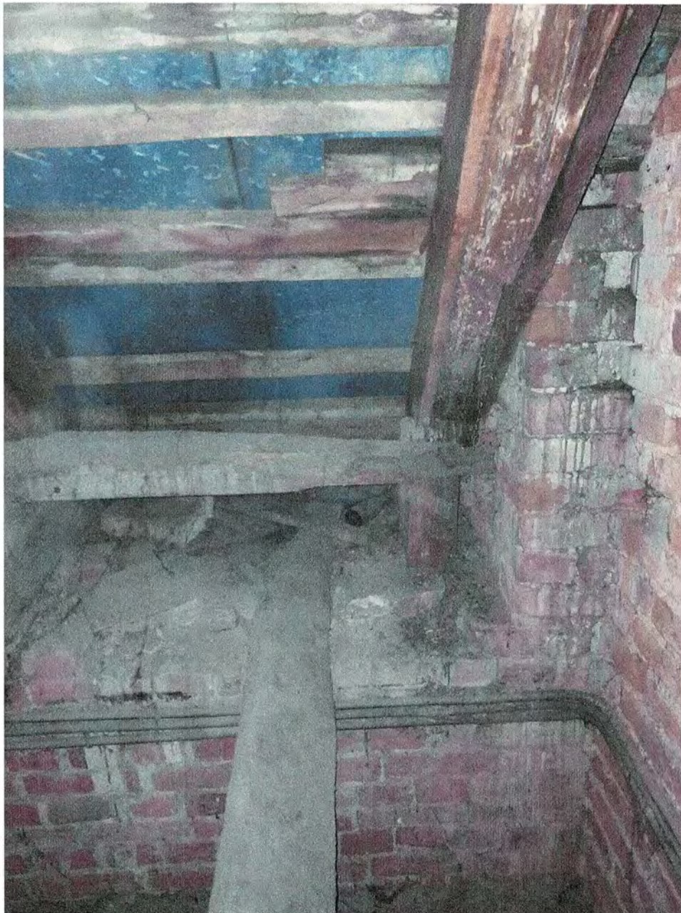
Zdjęcie nr 2. Widoczne zawilgocenie krokwi z powodu nieszczelności dachu
