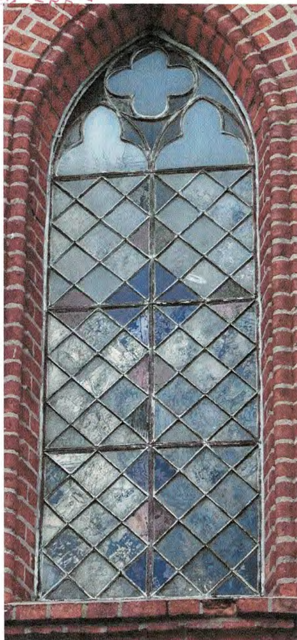
Zdjęcie nr 3. Pęknięcia szyb spowodowane naprężeniami wywoływanymi przez stalowe ramy
