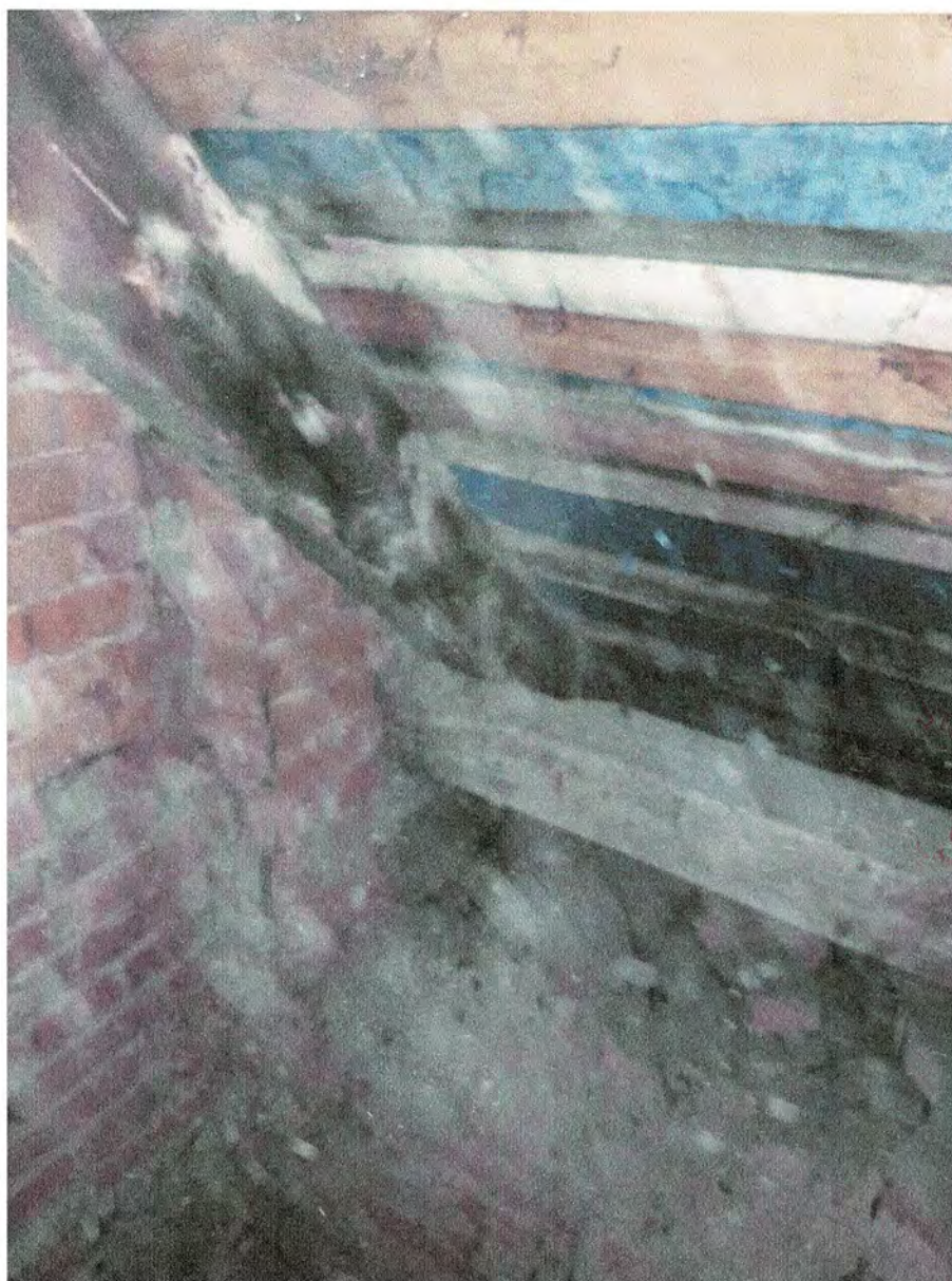
Zdjęcie nr 4. Zniszczona przez zacieki wodne część krokwi
