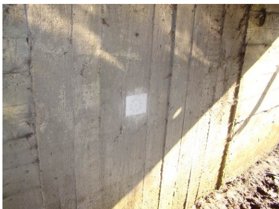
Fot. 5 Podpora po stronie wschodniej. Ogólnie dobry stan podpór
