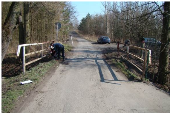
Fot. 1 Wjazd na obiekt od strony zachodniej
