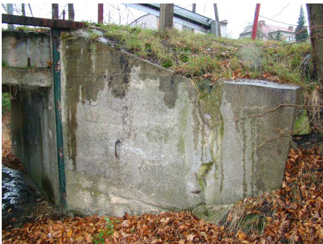
Fot.8 Skrzydło południowe od strony wlotu - Widok od północnego-zachodu
