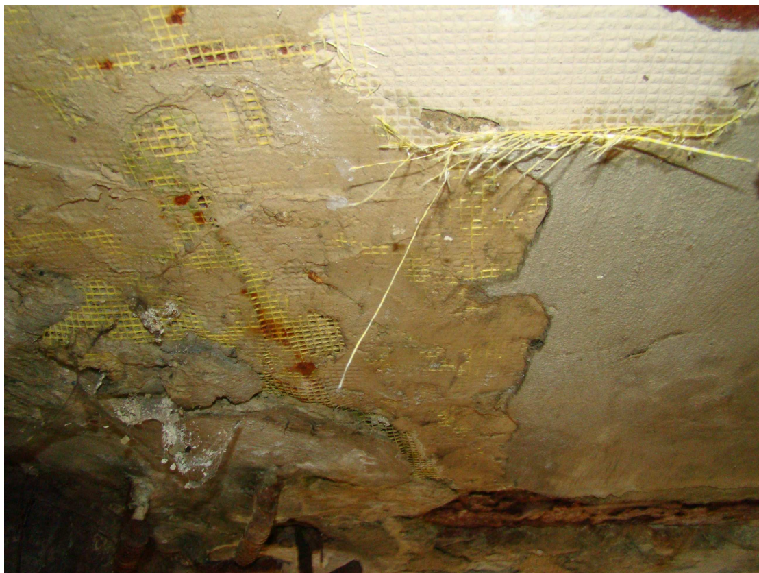
Fot.23 Widok spodu płyty pomostowej
