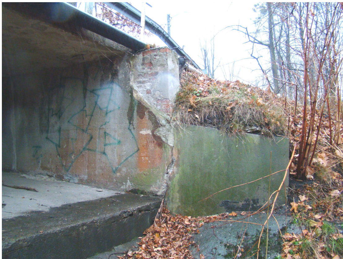
Fot.15 Skrzydło północne od strony wylotu - Widok od południowego-wschodu
