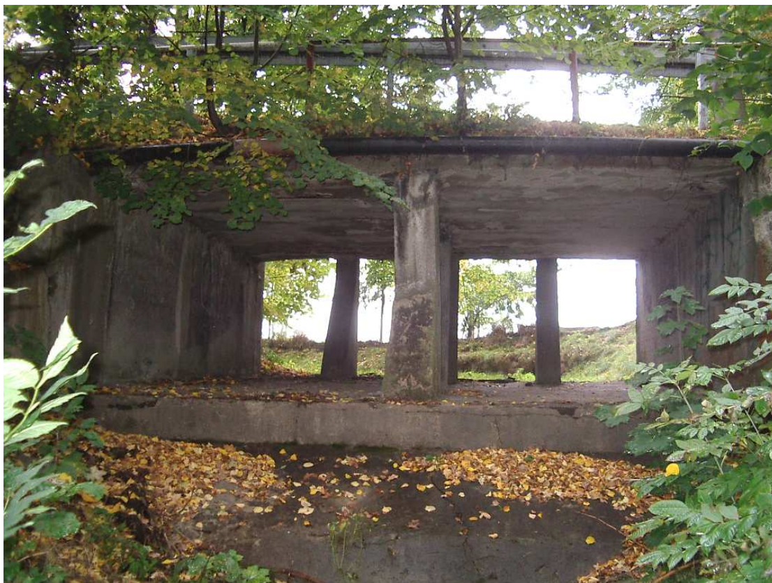
Fot.13 Widok od strony wschodniej (wylot)
