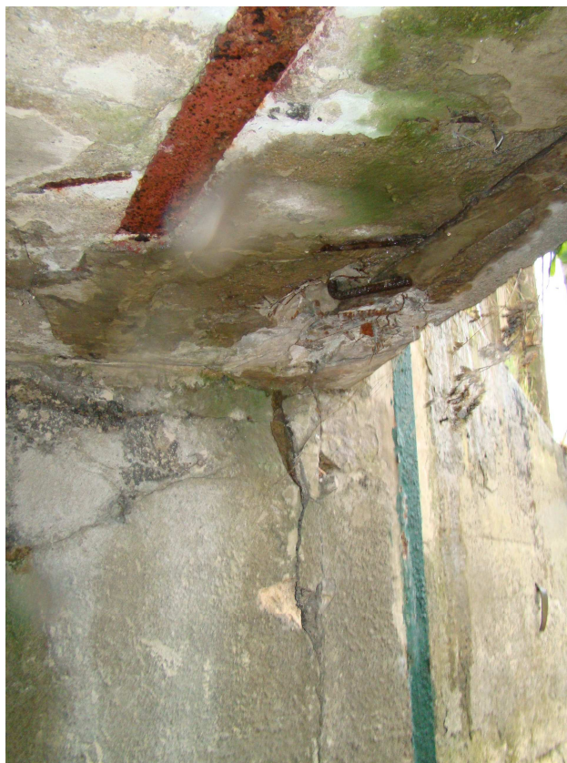
Fot.19 Widok na ścianę przyczółka południowego – część od strony zachodniej
