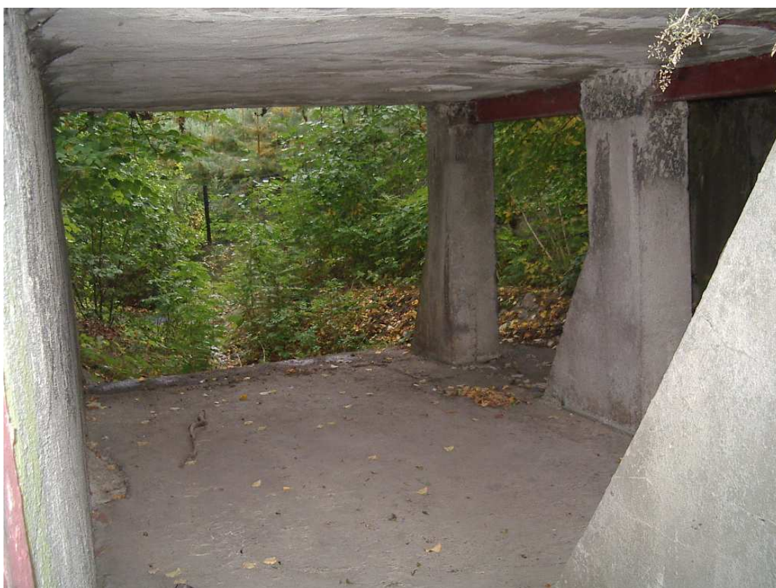
Fot.6 Widok od strony zachodniej
