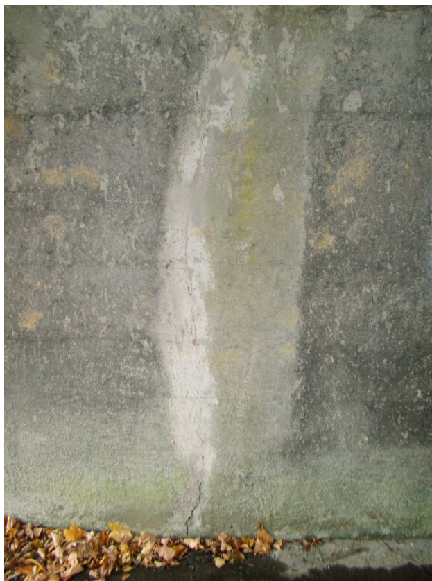
Fot.25 Widok na ścianę przyczółka południowego
