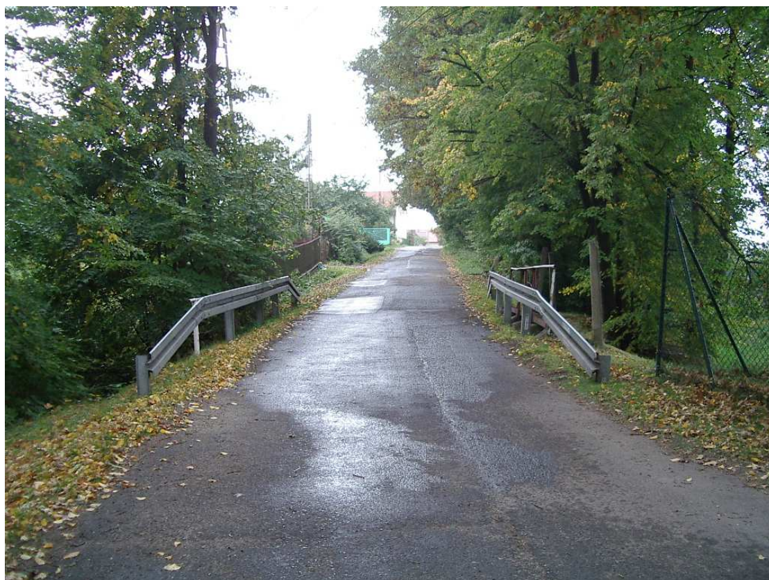
Fot.2 Widok w kierunku południowo-zachodnim (kierunek Sośnicowice)
