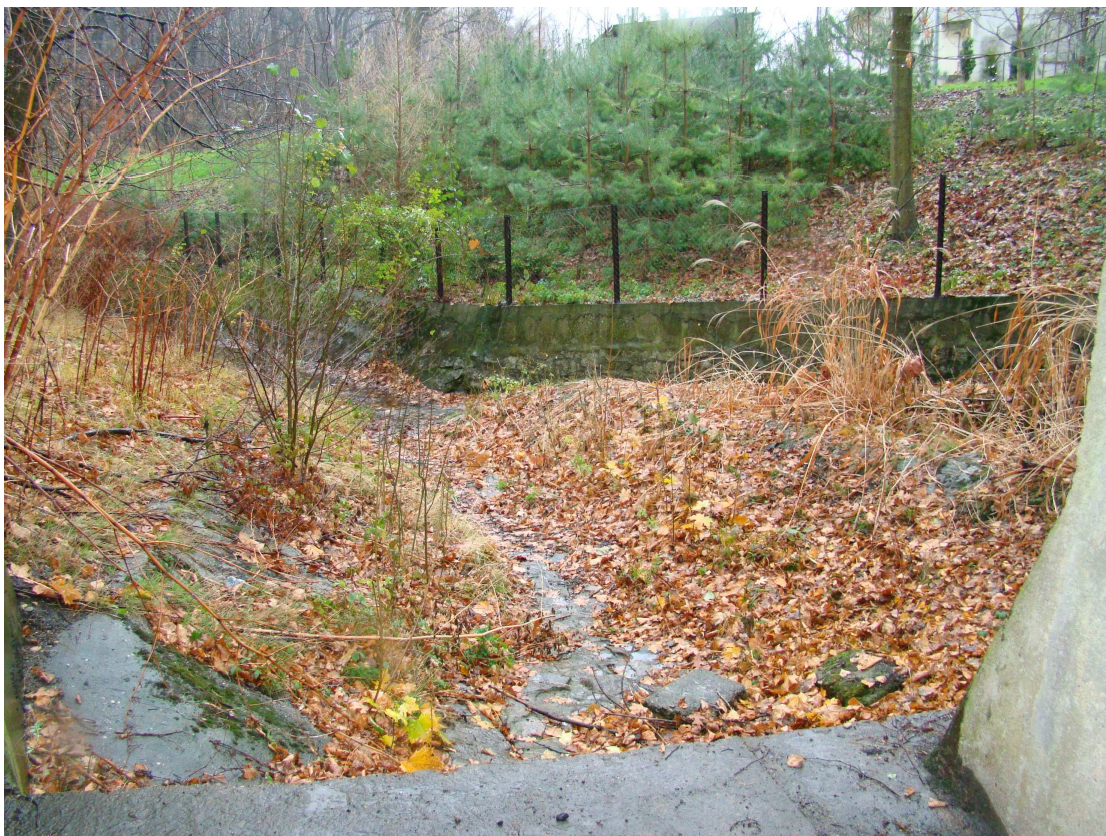
Fot.17 Widok od strony wylotu w kierunku południowo-wschodnim
