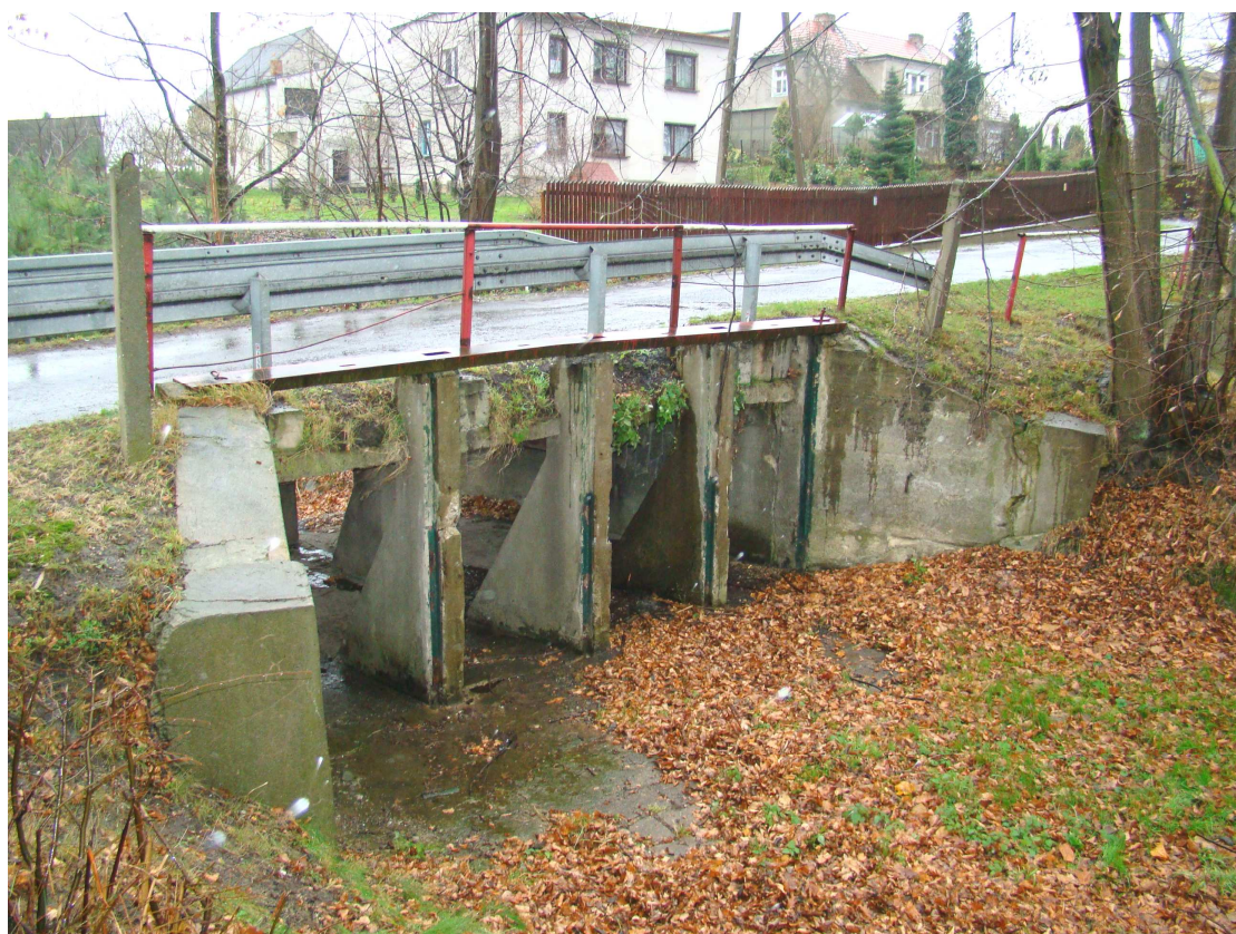
Fot.4 Widok w kierunku południowo-wschodnim (wlot)
