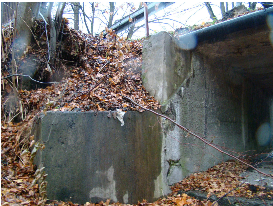
Fot.14 Skrzydło południowe od strony wylotu - Widok od północnego-wschodu
