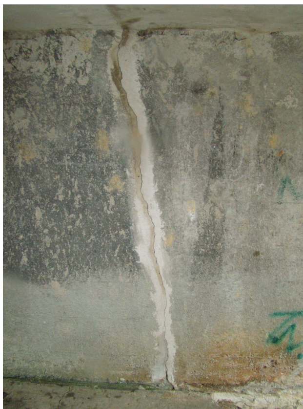
Fot.24 Widok na ścianę przyczółka północnego
