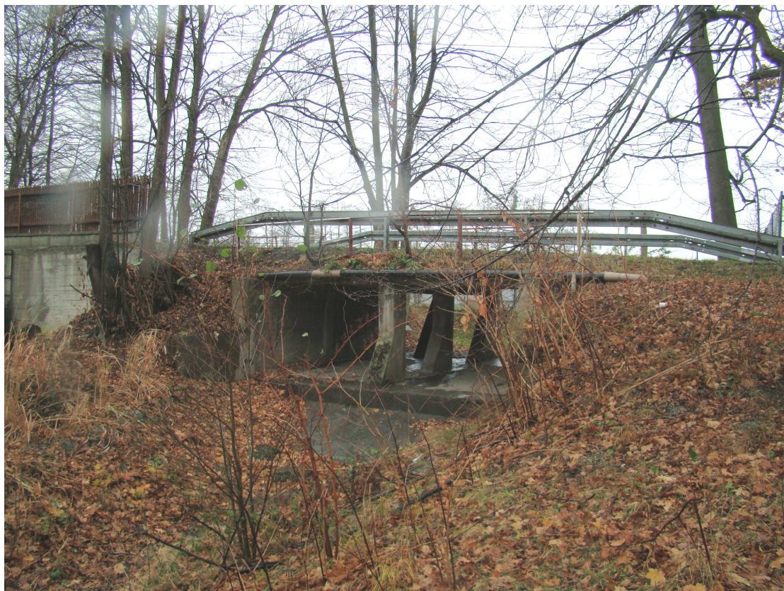
Fot.11 Widok od strony wschodniej (wylot)
