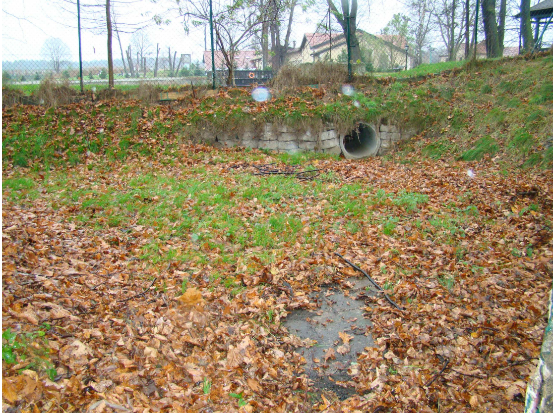
Fot.9 Widok od strony wlotu w kierunku istniejącego stawu (na zdjęciu przepust rurowy – zastawka istniejącego stawu) - Widok od południowego wschodu
