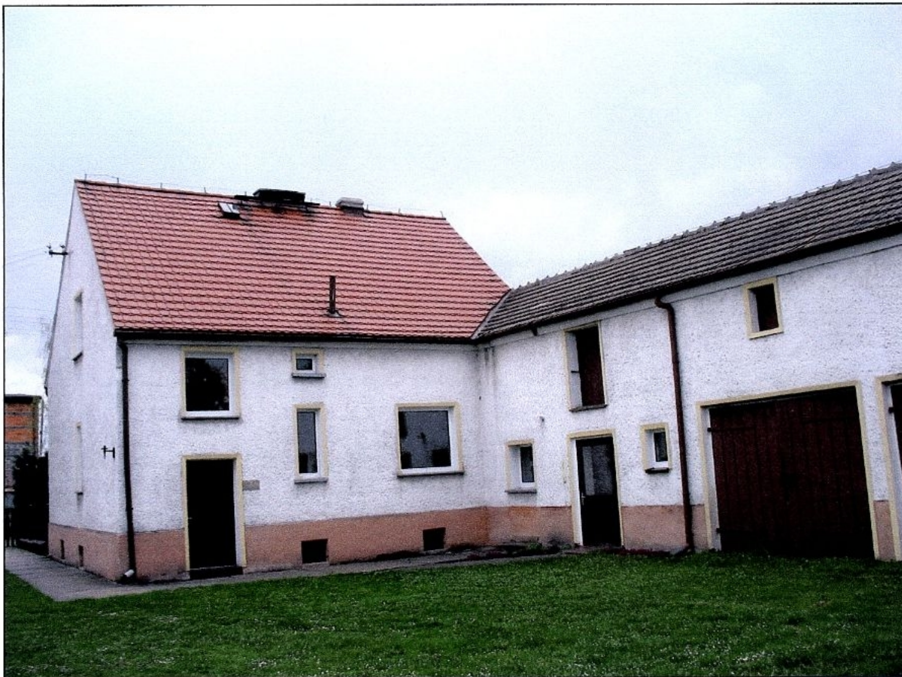
Gmina Sośnicowice, obręb Łany Wielkie, ul. Wiejska 47 Widok budynku od strony zaplecza
