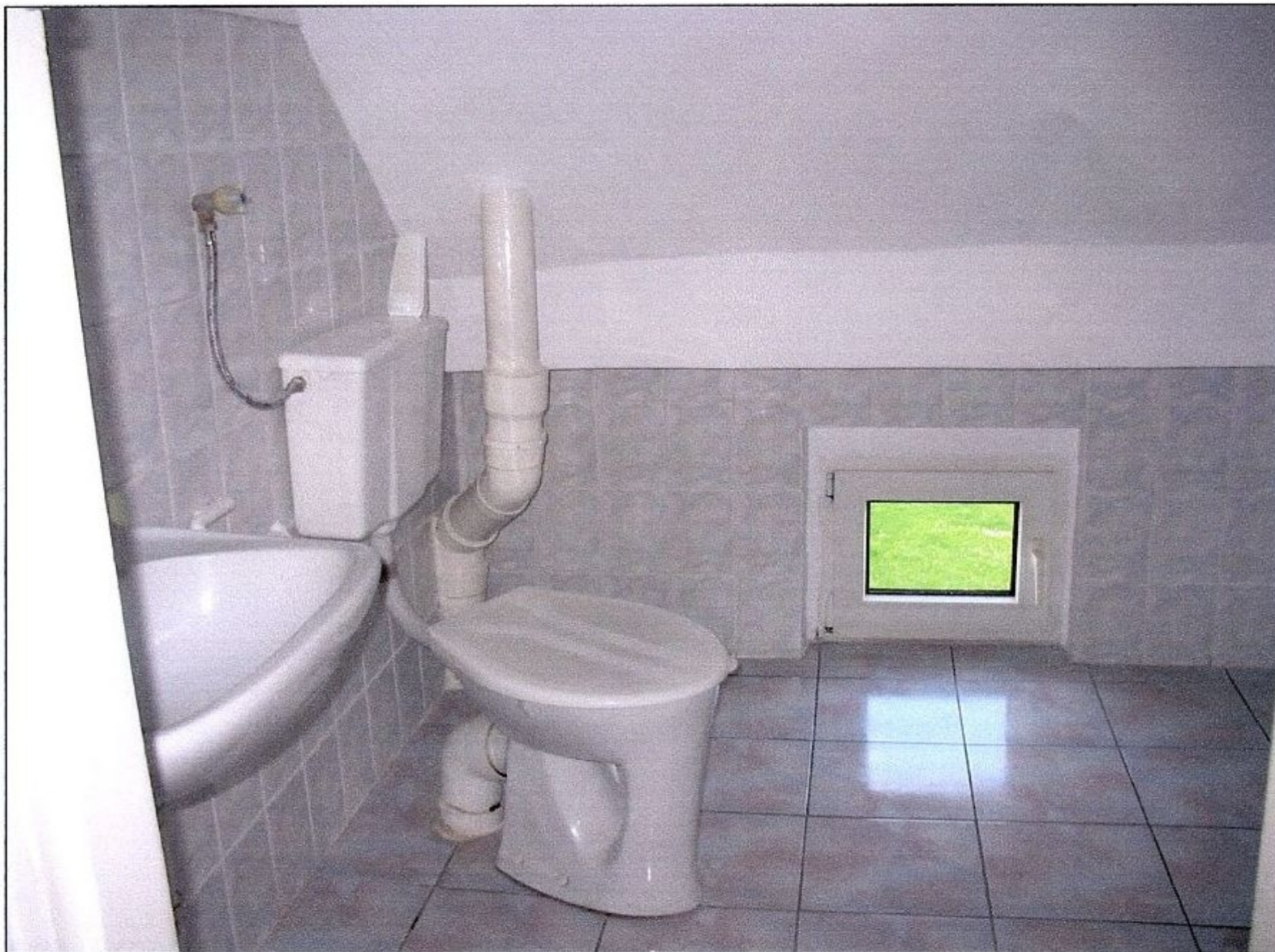
Gmina Sośnicowice, obręb Łany Wielkie, ul. Wiejska 47 WC na poddaszu
