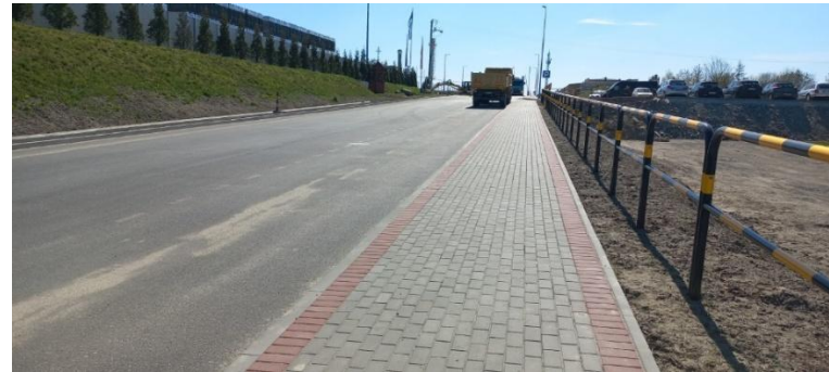
Ryc. 15.2.1 Inwestycja realizowana w ramach zadania „Budowa drogi przy ul.Kozielskiej w Sierakowicach wraz z kanalizacją deszczową i sanitarną”
