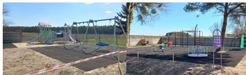
Ryc. 15.1.2 Inwestycja zrealizowana w ramach zadania: „Budowa placu zabaw przy ul. Raciborskiej w Trachach”
