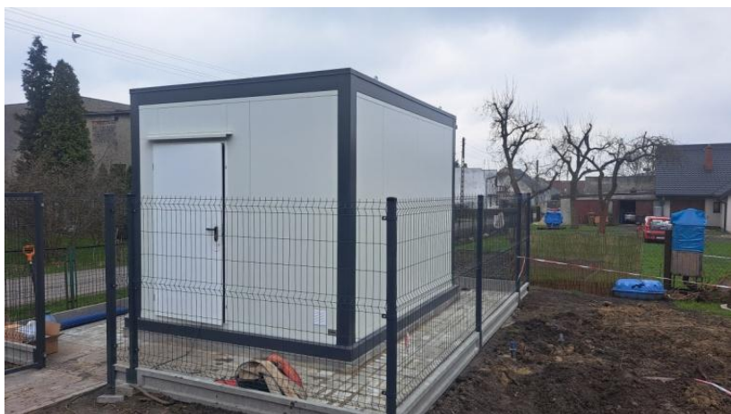
Ryc. 15.2.4 Inwestycja realizowana w ramach zadania „Budowa kontenerowej przepompowni wody wraz z infrastrukturą techniczną w sołectwie Łany Wielkie”
