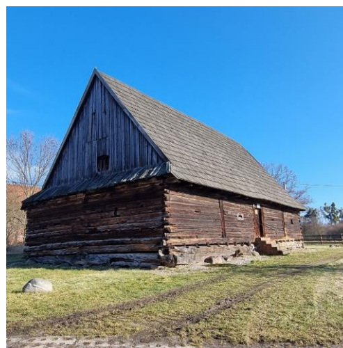
Fotografia 8. Widok na spichlerz drewniany w Rachowicach.
