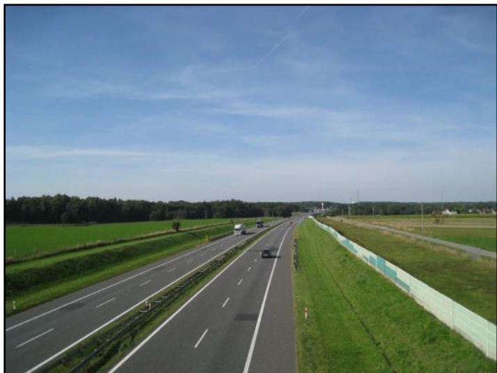
Fot. 16 Autostrada A1 w Kozłowie
