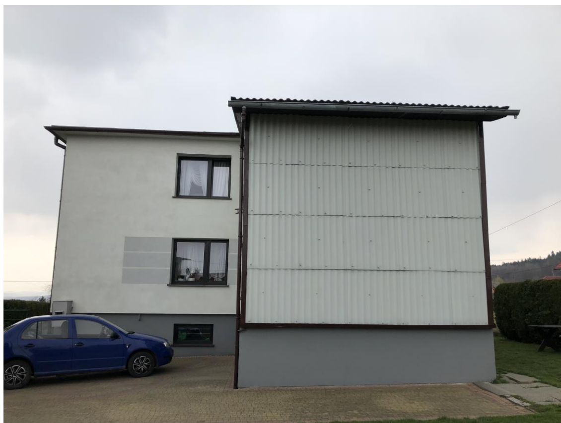
Rysunek 15 Wyroby faliste zawierające azbest
