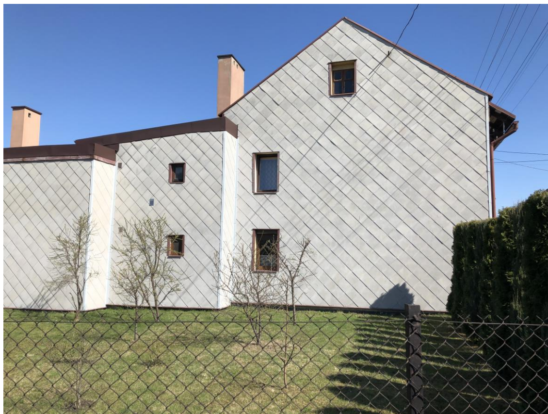
Rysunek 14 Wyroby płaskie zawierające azbest
