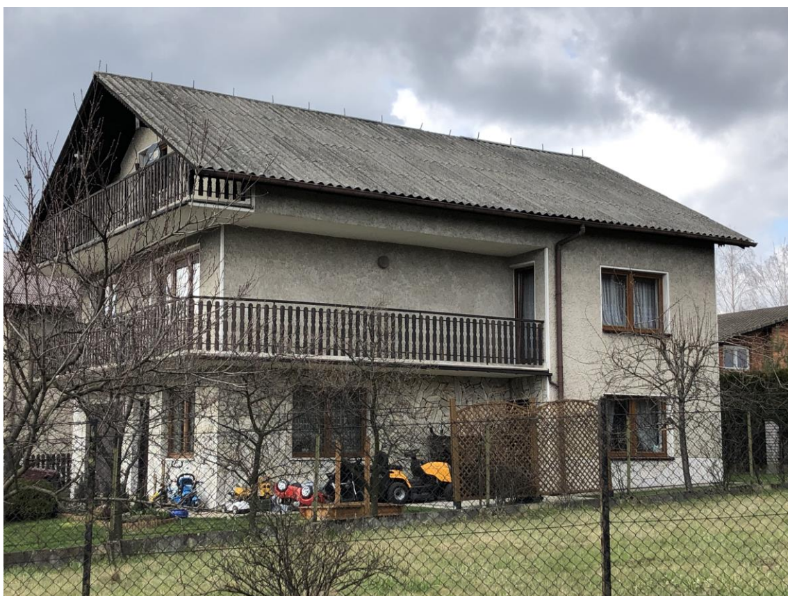
Rysunek 18 Wyroby zawierające azbest na dachu
