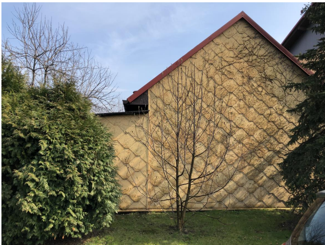
Rysunek 17 Wyroby zawierające azbest na elewacji
