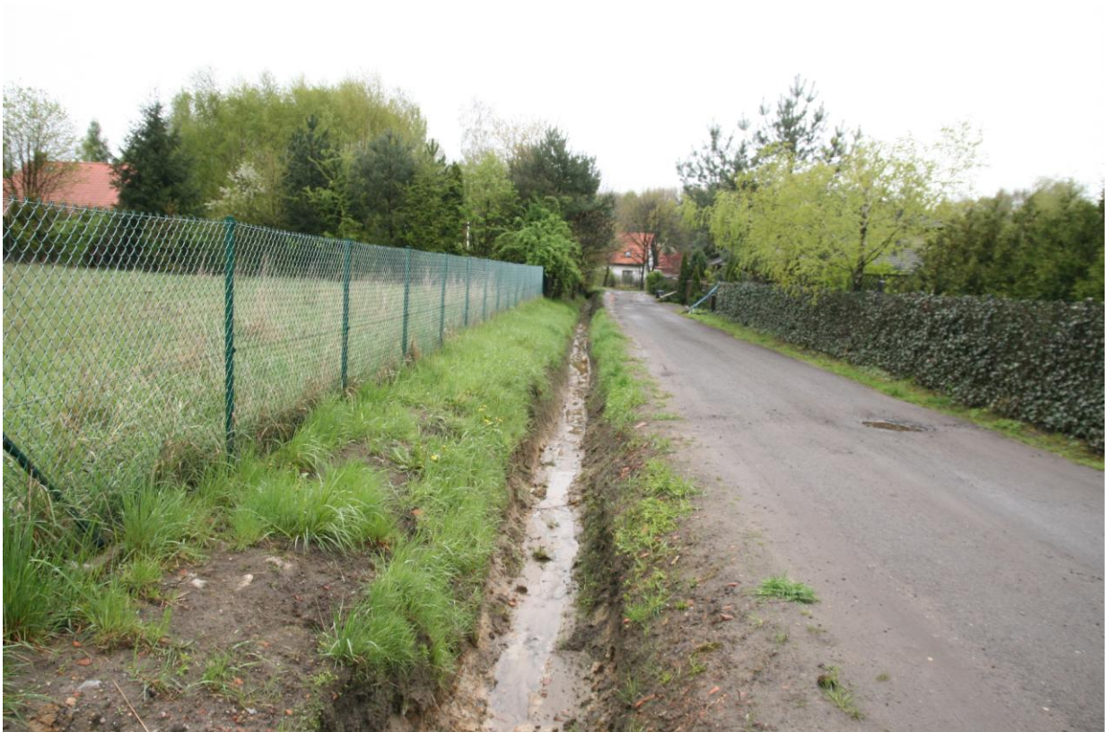
Zdj nr 2 Widok na istniejący rów przydrożny, do którego będą odpr. Wody opadowe”
