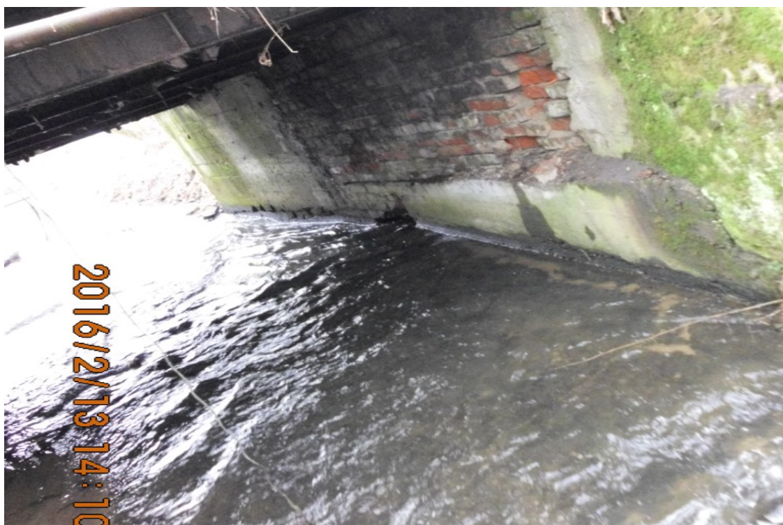
Zdjęcie 3.12 :Przestrzeń podmostowa
