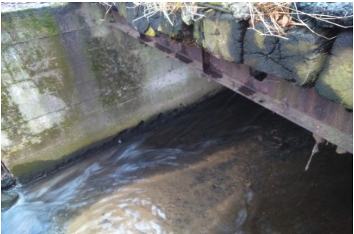
Zdjęcie nr 3.6 : Betonowy fragment przyczółka
