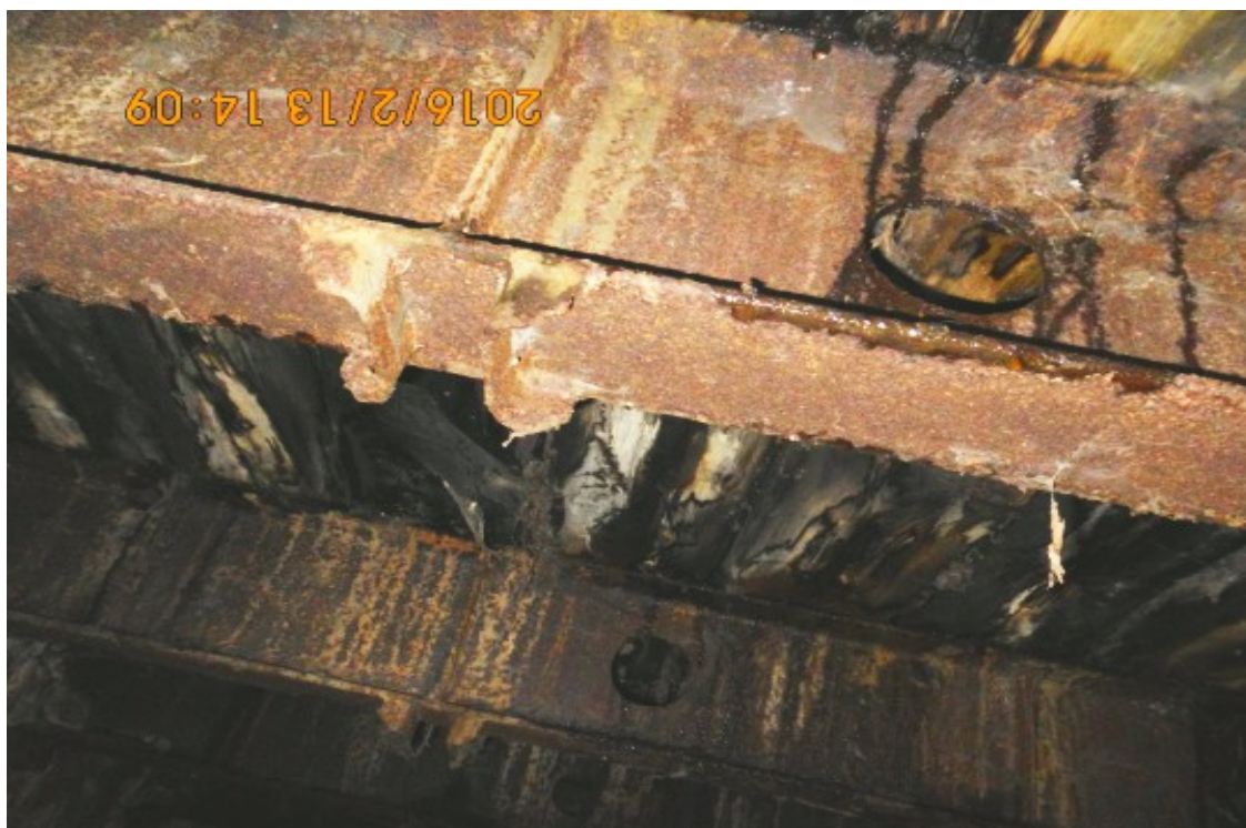
Zdjęcie 3.11 : Widok konstrukcji nośnej od spodu mostu
