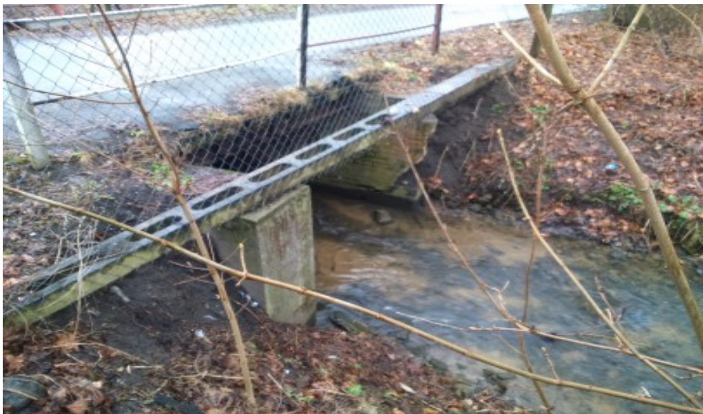
Widok ogólny obiektu mostowego
