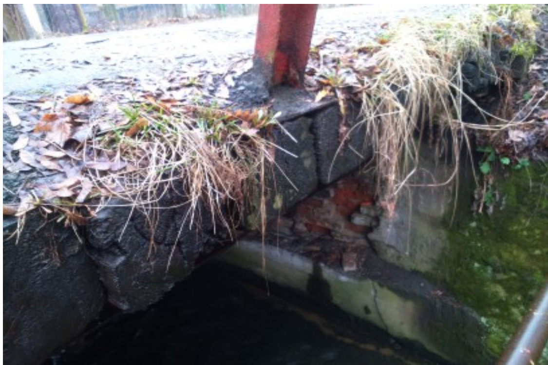
Zdjęcie 3.9 : Szczegół pomostu i zamocowania słupków balustrady.
