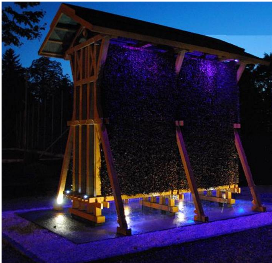
fotografia poglądowa, w projektowanej tężni zadaniem jest dach altany, do którego mocowane będą elementy tężni
