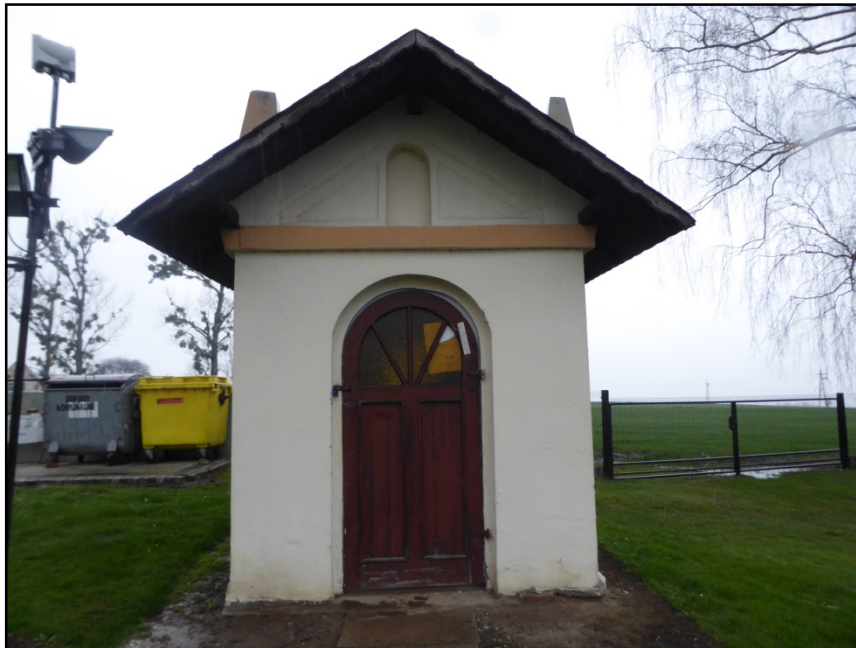
Fot. 3. Elewacja południowa
