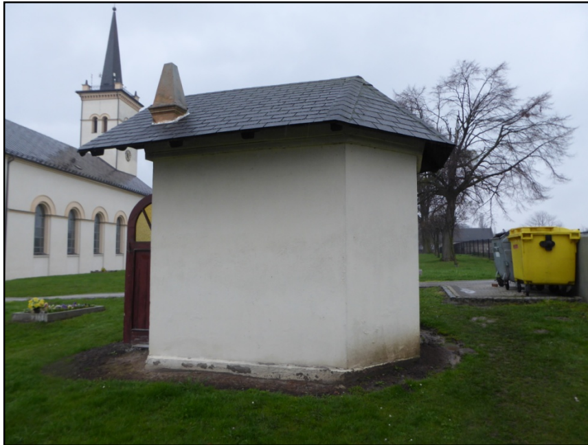
Fot. 1. Elewacja wschodnia
