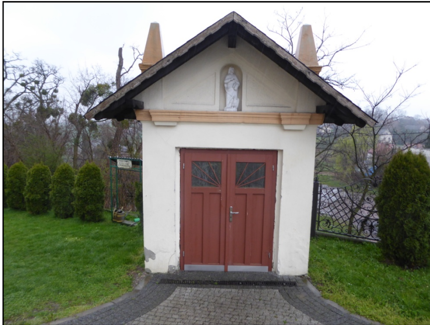
Fot. 2. Elewacja północna
