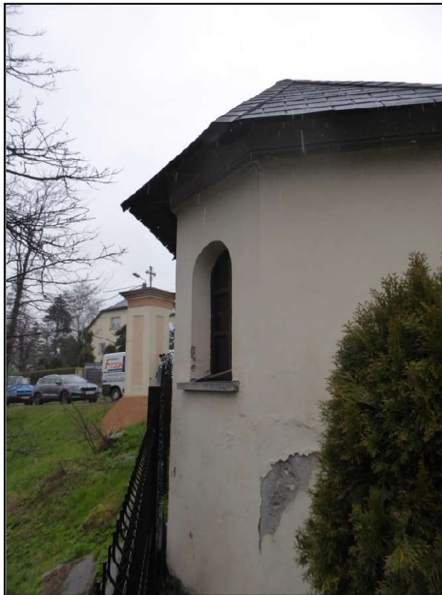
Fot. 3. Elewacja południowa
