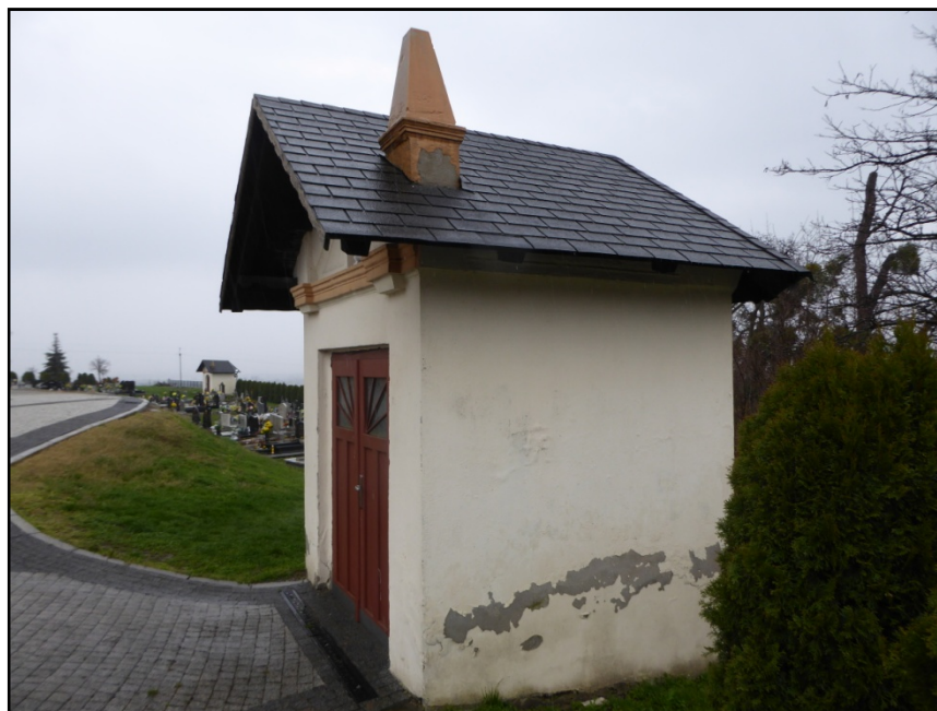
Fot. 4. Elewacja zachodnia
