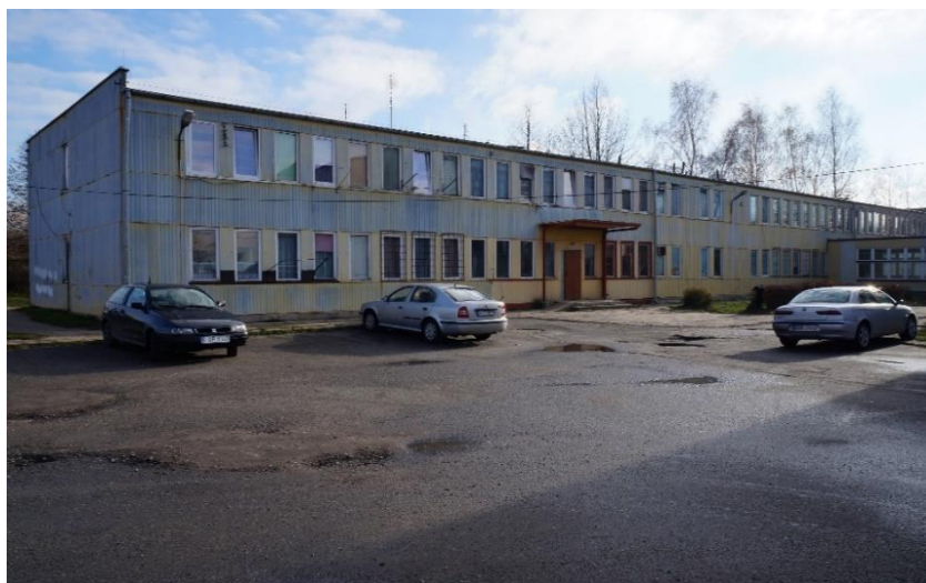
Fotografia 21 Bloki mieszkalne przy ul. Przemysłowej w Opocznie – 1
