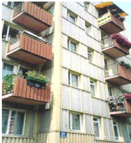
Zdjęcie 10 Elewacja wykonana z płyt azbestowo-cementowych płaskich
