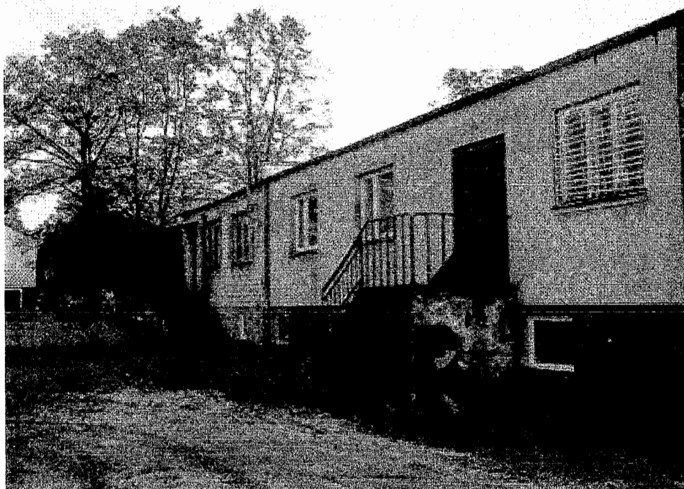
Zdjęcie 3. Świetlica Wiejska w Stuznie.
