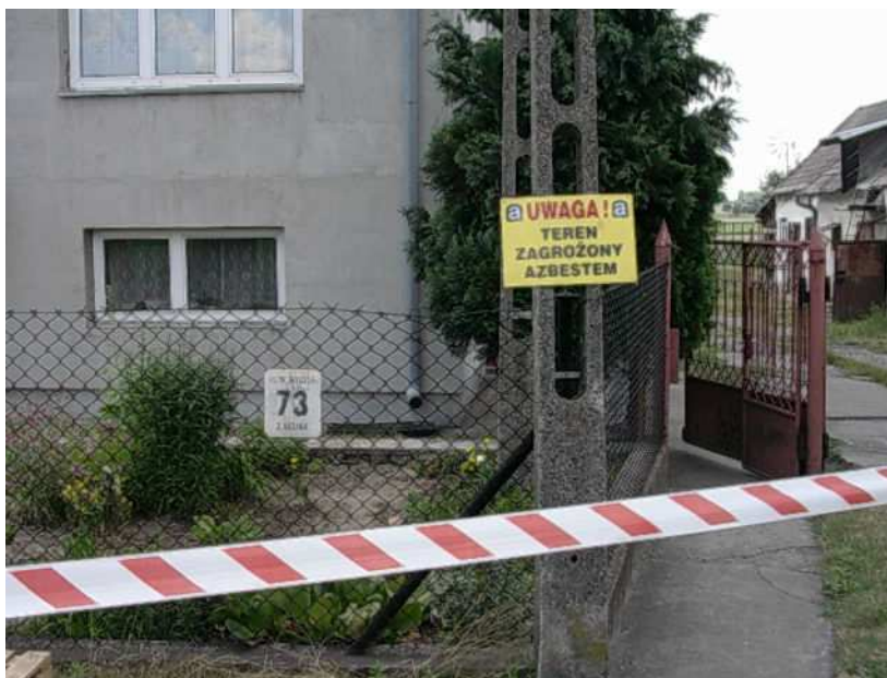
Zdjęcie nr 7. Prawidłowy sposób zabezpieczenia terenu zagrożonego azbestem.
