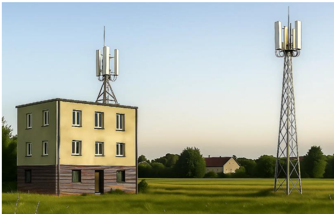
Rysunek 5. Stacje bazowe telefonii komórkowej: zainstalowana na dachu budynku oraz wolnostojąca Źródło: opracowanie własne
