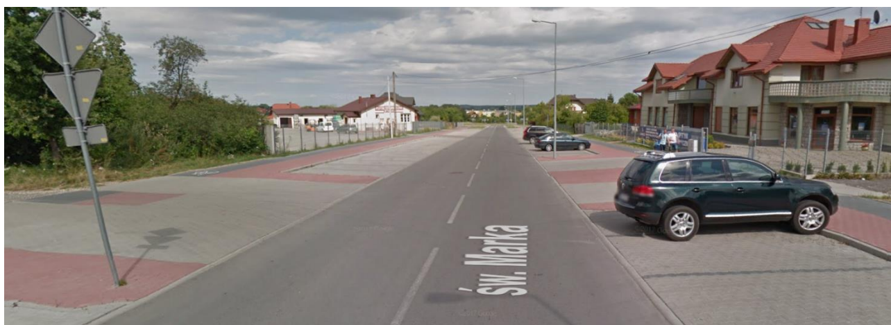
Zdjęcie 11. Ulica Św, Marka z dużym udziałem przestrzeni nieprzepuszczalnych (źródło: Google Street View).
