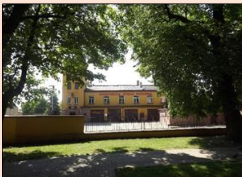
Zdjęcie 4. Opoczno Plac Strażacki (źródło: InicjatywaLokalna.pl).
