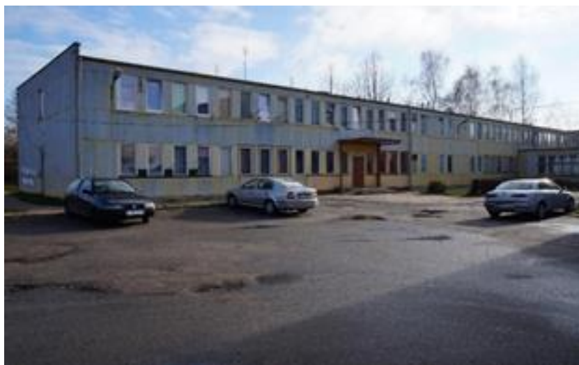
Fotografia 21 Bloki mieszkalne przy ul. Przemysłowej w Opocznie – 1
