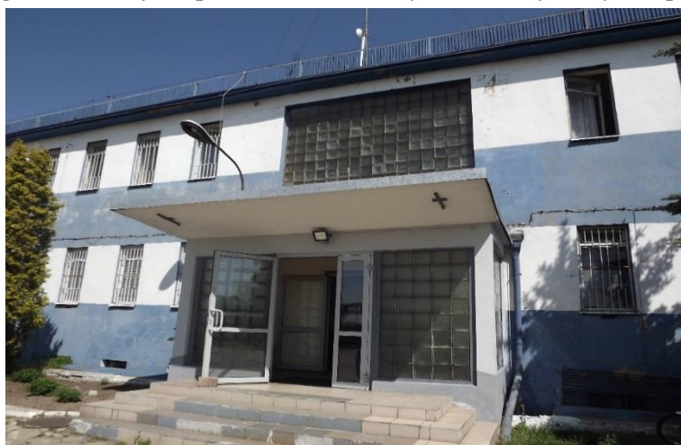
Fotografia 15 Budynek po siedzibie Komendy Powiatowej Policji w Opocznie
