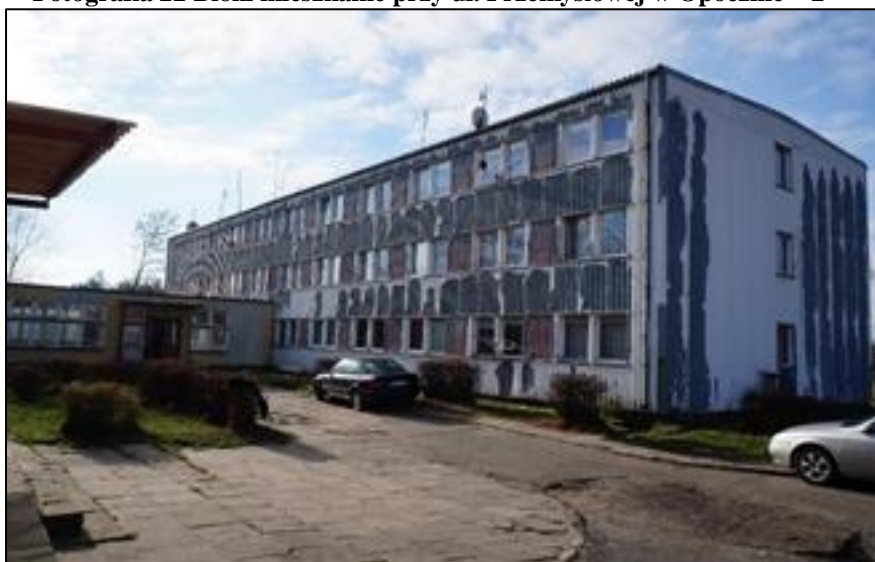
Fotografia 22 Bloki mieszkalne przy ul. Przemysłowej w Opocznie – 2
