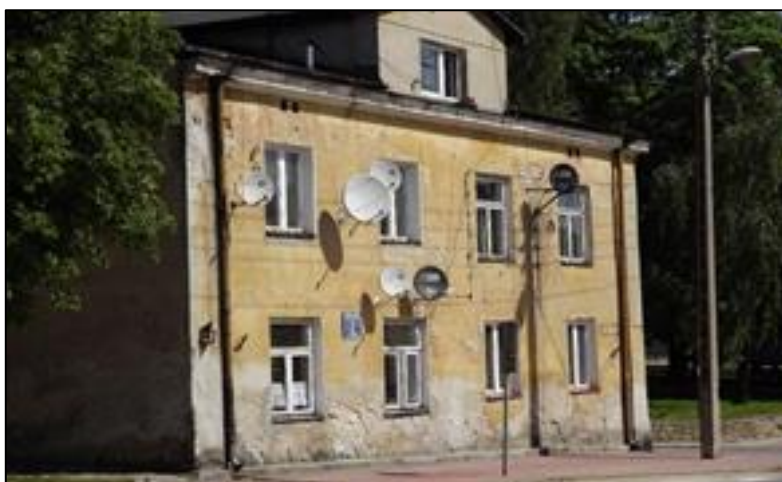
Fotografia 12 Budynek mieszkalny przy ul. Janasa 2
