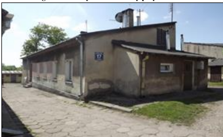
Fotografia 13 Budynek mieszkalny przy ul. Janasa 17
