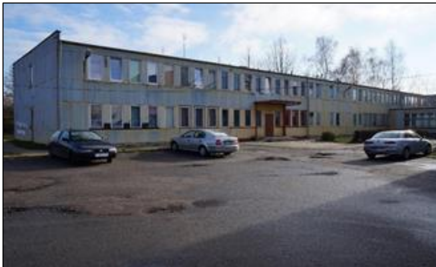
Fotografia 21 Bloki mieszkalne przy ul. Przemysłowej w Opocznie – 1
