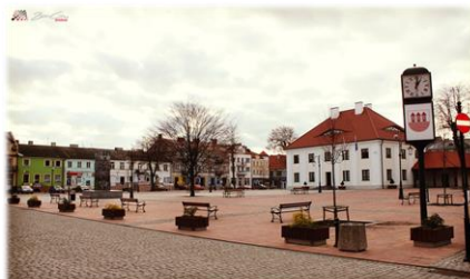
Rynek po przeprowadzeniu prac remontowych.
