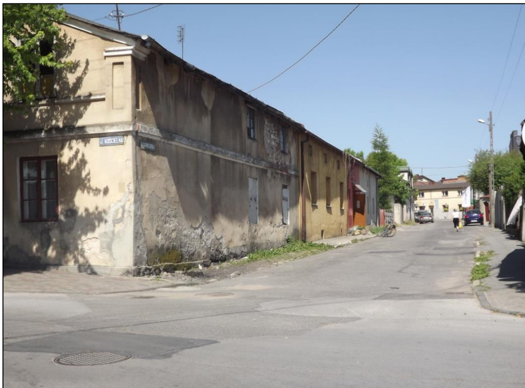
Fotografia 15 Ulica Garncarska (widok od strony ul. Kościelnej)
