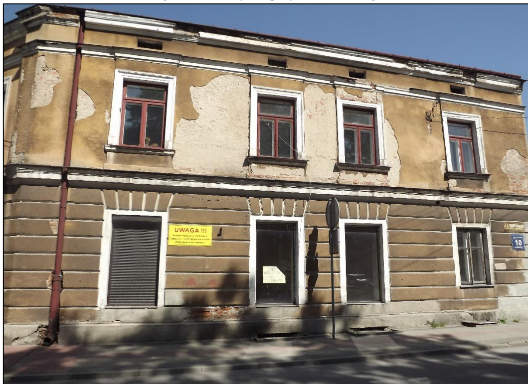
Fotografia 13 Budynek przy ul. Sobieskiego 10
