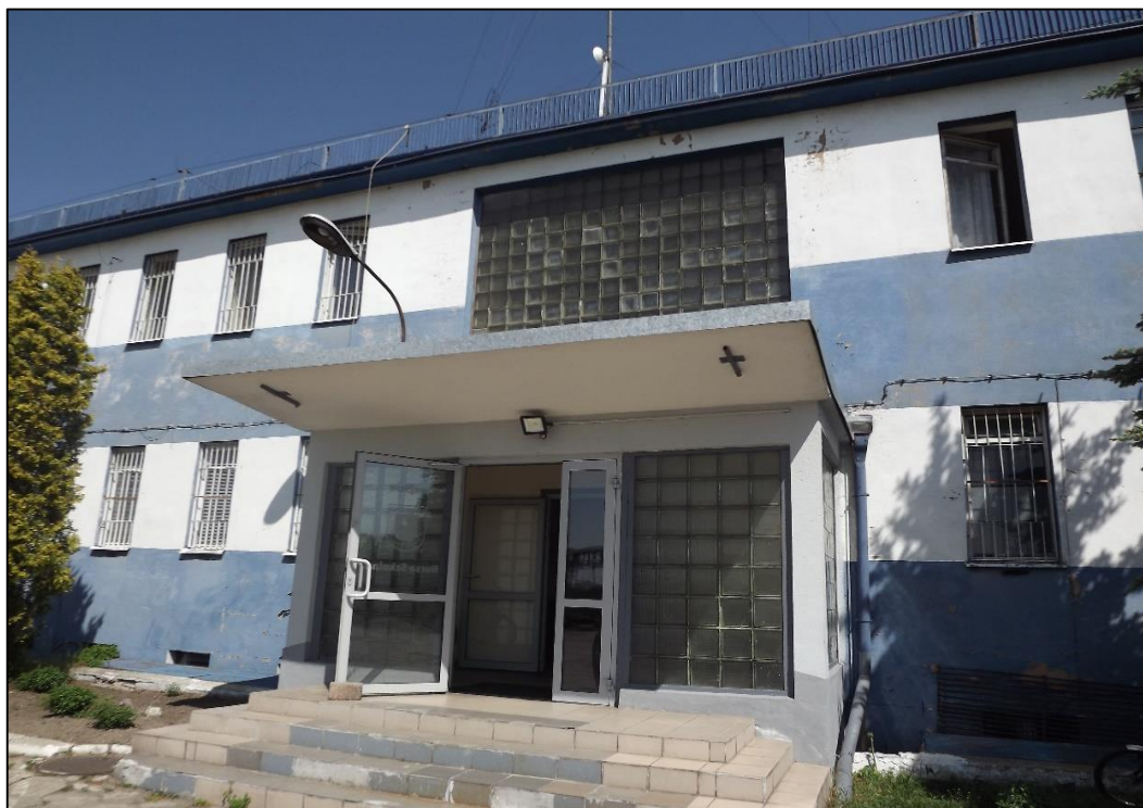
Fotografia 6 Budynek po siedzibie Komendy Powiatowej Policji w Opocznie
