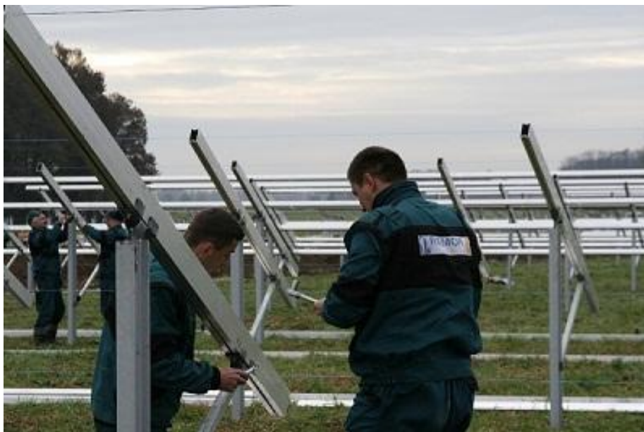
Zdjęcie 23. Montaż szkieletów przed montażem paneli, farma solarna NIENBURG 4 MW (Niemcy) (Remor Solar)
