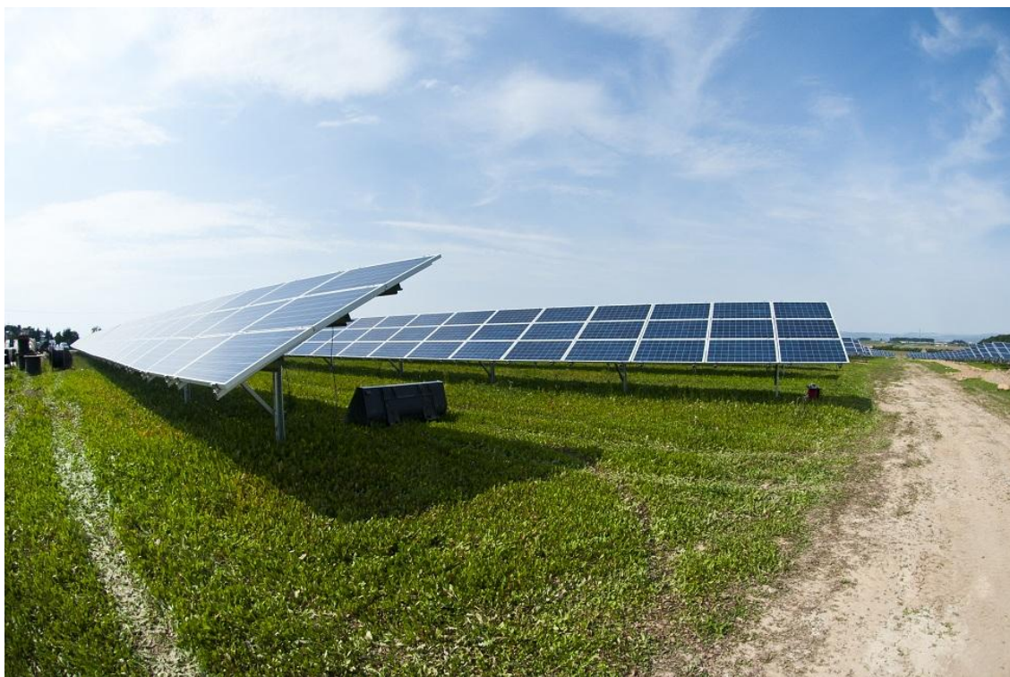
Zdjęcie 10. Nieutwardzona ścieżka techniczna wokół terenu inwestycji (farma solarna Bautzen Niemcy 38MW, Remor Solar)
