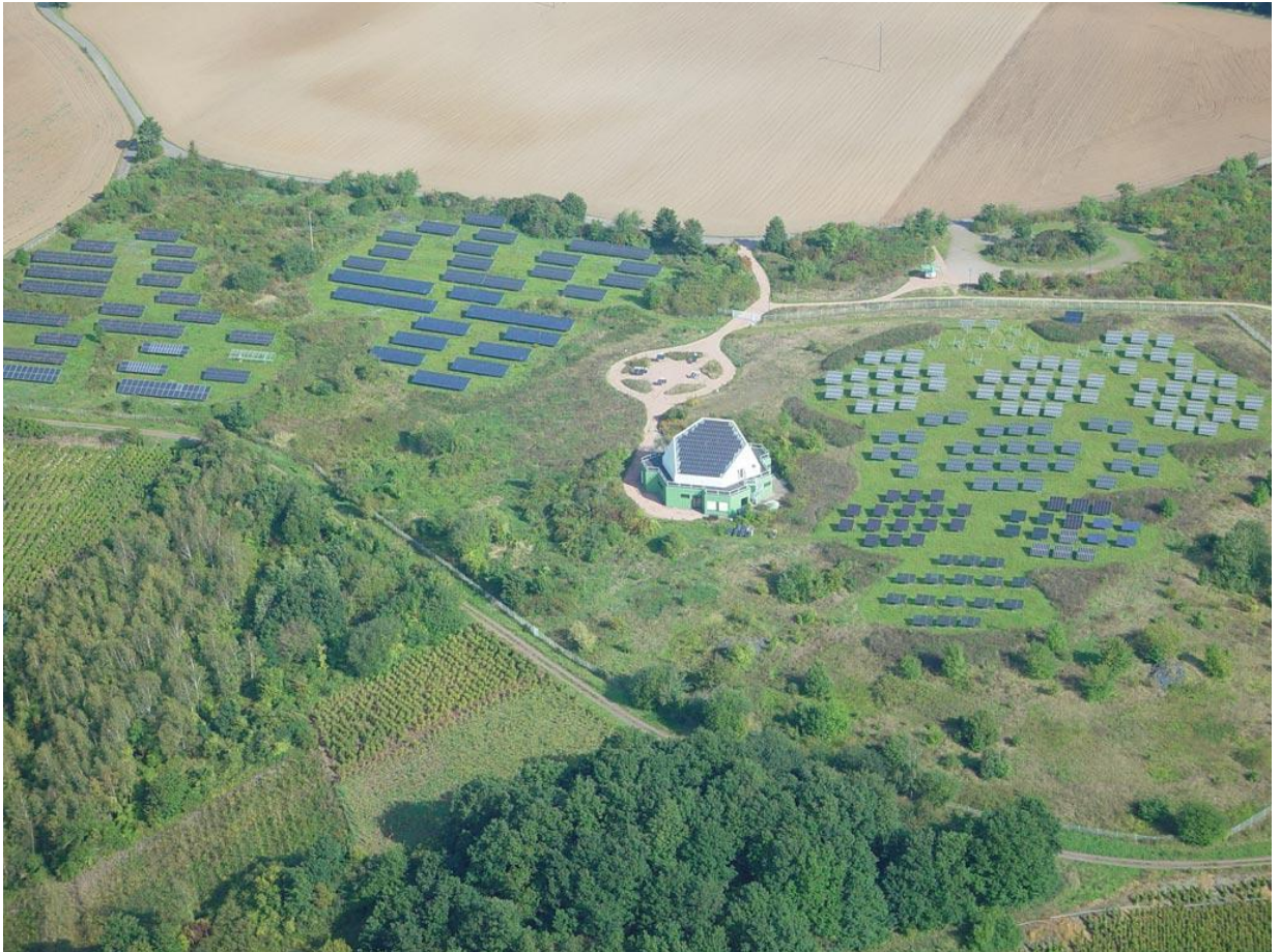
Zdjęcie 15. Instalacja fotowoltaiczna o mocy 650 kW w niemieckim Kobern Gondorf. Źródło: Vivasolar.de
