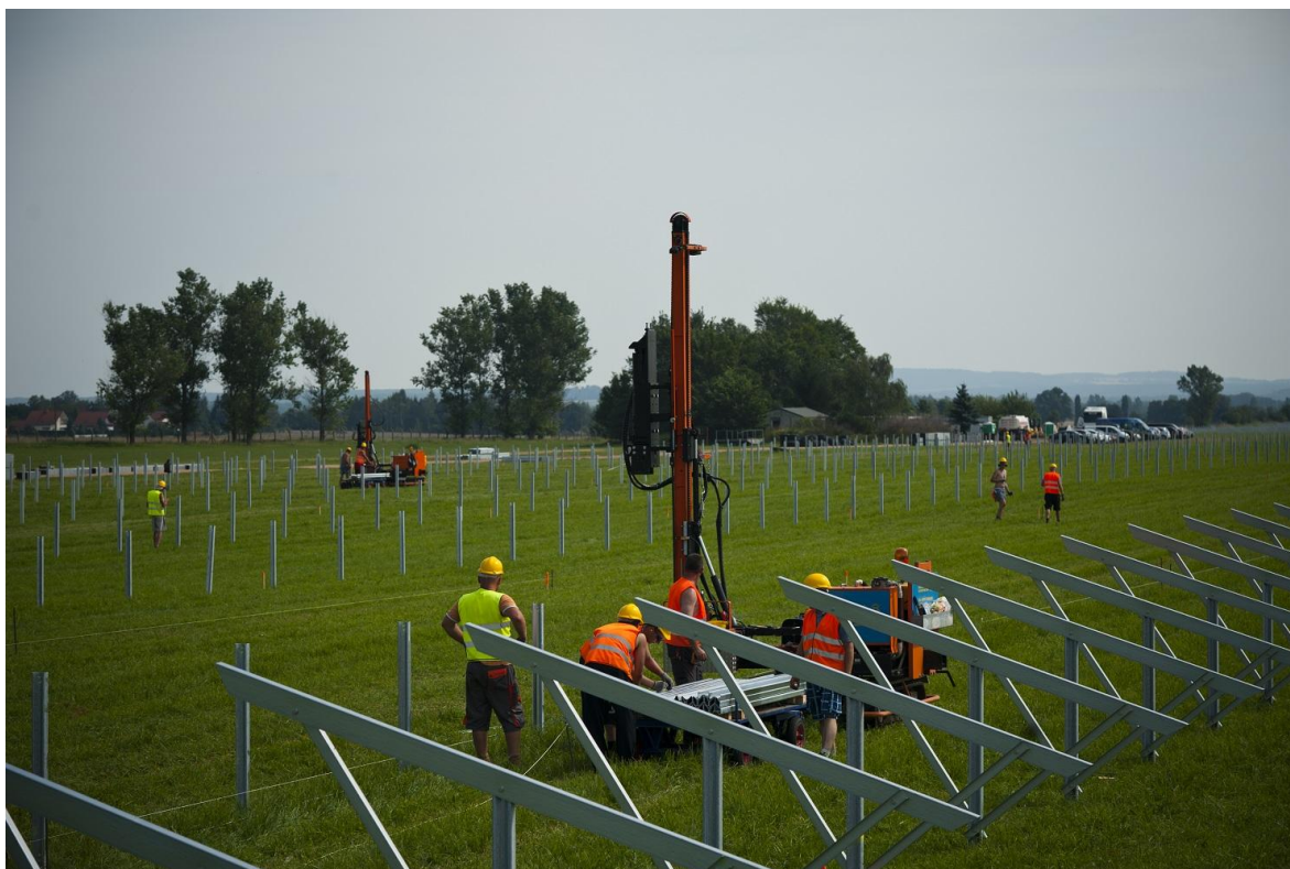
Zdjęcie 7. Wiertnica wykorzystywana podczas procesu osadzania konstrukcji montażowej (REMOR SOLAR Recz)
