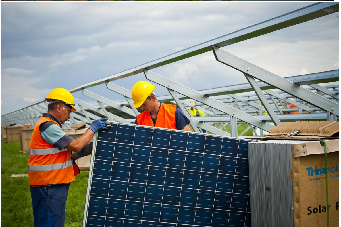
Zdjęcie 8, Zdjęcie 9. Budowa farmy solarnej Bautzen (Niemcy) 38MW na powierzchni ok. 70ha przez polską firmę Remor Solar z Recza (Remor Solar)
