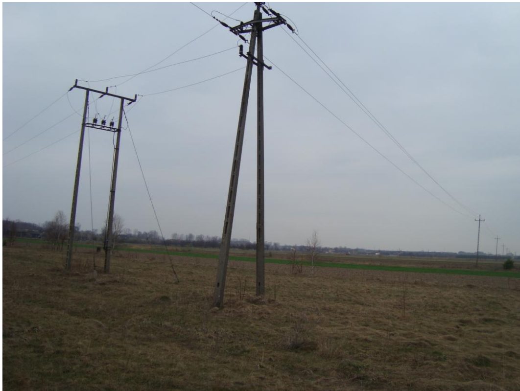
Zdjęcie 6. Istniejąca linia SN na działce 1202/2, do której przyłączona zostanie projektowana instalacja PV.
